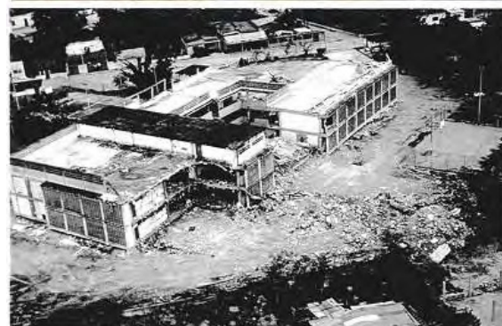
Figura 45. Terremoto de Cariaco 1997. Derrumbe Liceo RMC. Primer piso enterrado. F / Google Imágenes.
