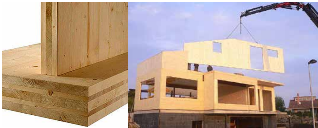
Imagen 2. Laminado y contralaminado. Detalle secciones y componente
