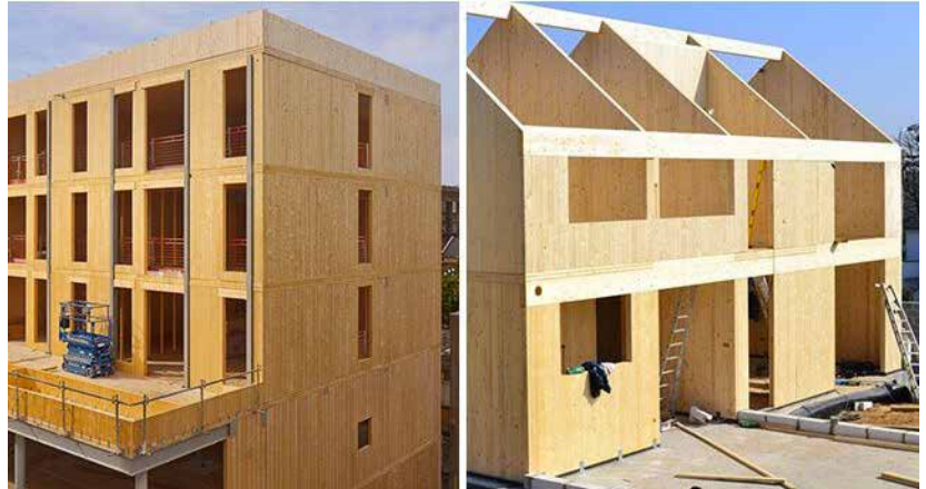
Imagen 3. Construcciones con tecnología CLT: paneles de madera contralaminada
