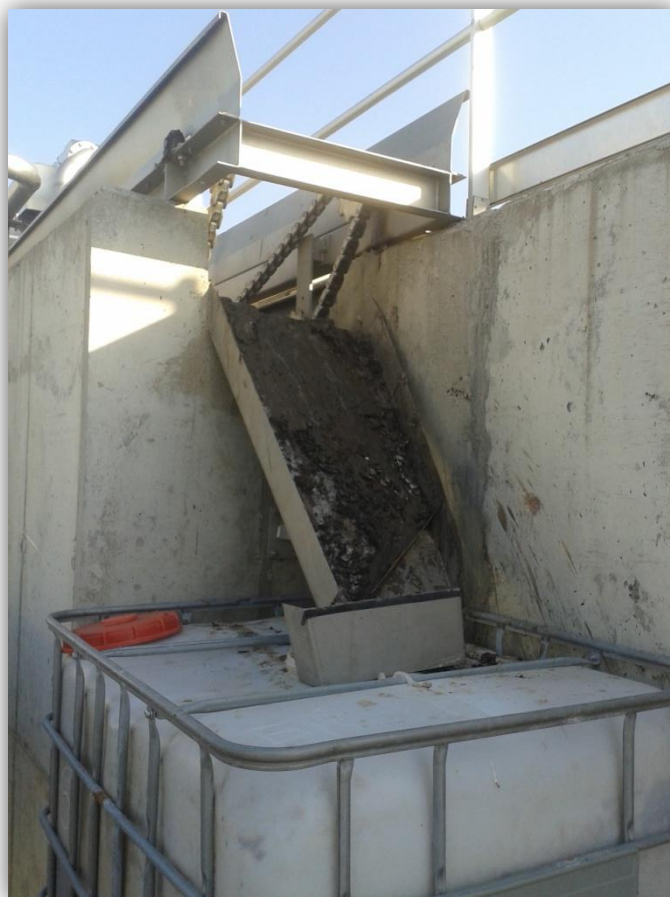
Figura 8 Salida del desengrador
