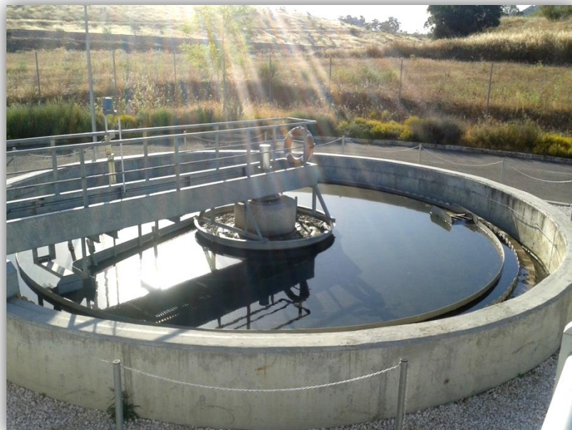
Figura 14. Decantador secundario
