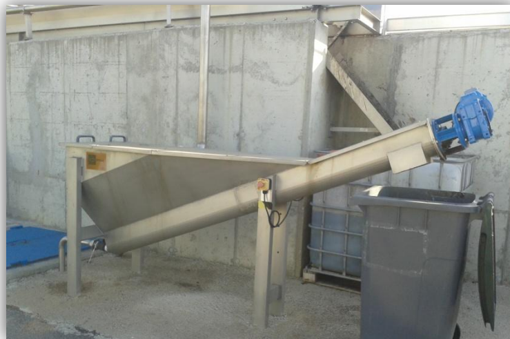
Figura 7 clasificador de arenas
