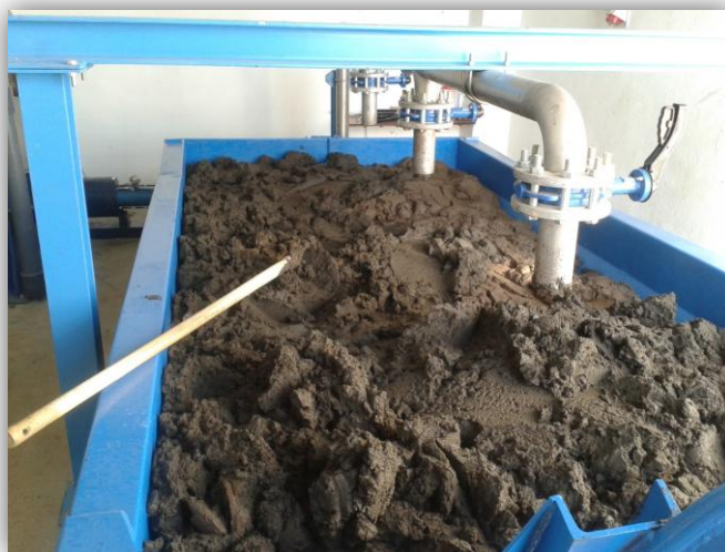
Figura 23 Almacén de lodos
