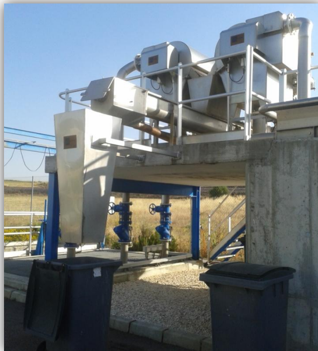
Figura 4. Tamices rotativos y tornillo sin fin.
