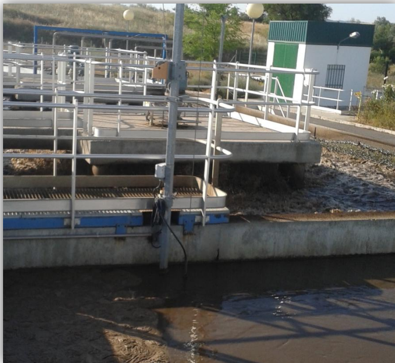
Figura 11. Cámara anóxica y cámara óxica
