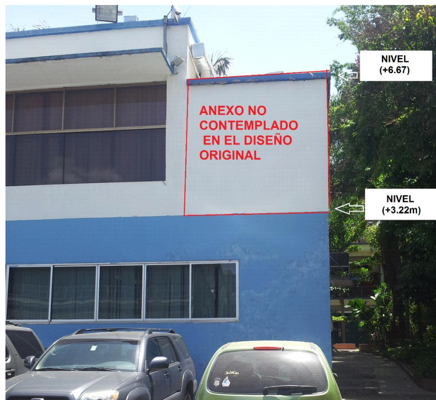
Figura 5.6 Fachada sur-este del módulo 6. Fuente: foto capturada el 27 de abril de 2014
