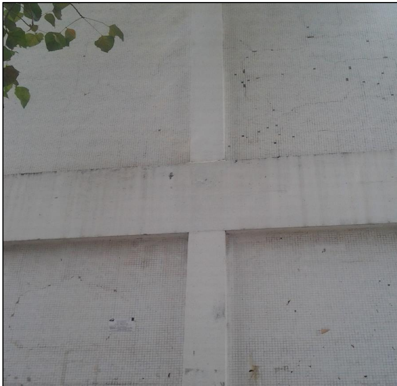
Figura 5.1 Columnas 3G (PB-P1) y 3G (P1-PT) del módulo 5. Fuente: foto capturada el 27 de febrero de 2014
