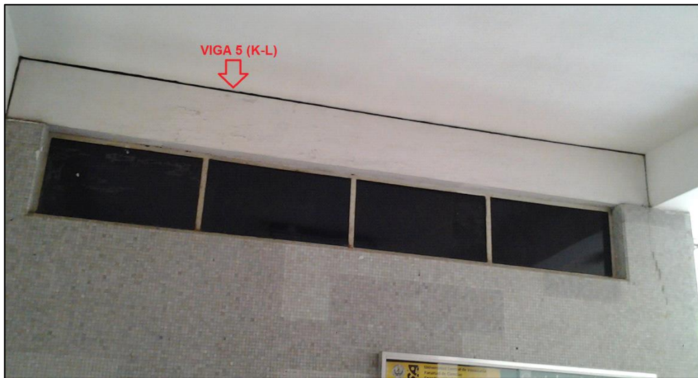
Figura 5.4 Viga de techo 5 (K-L) del módulo 6. Fuente: foto capturada el 27 de abril de 2014
