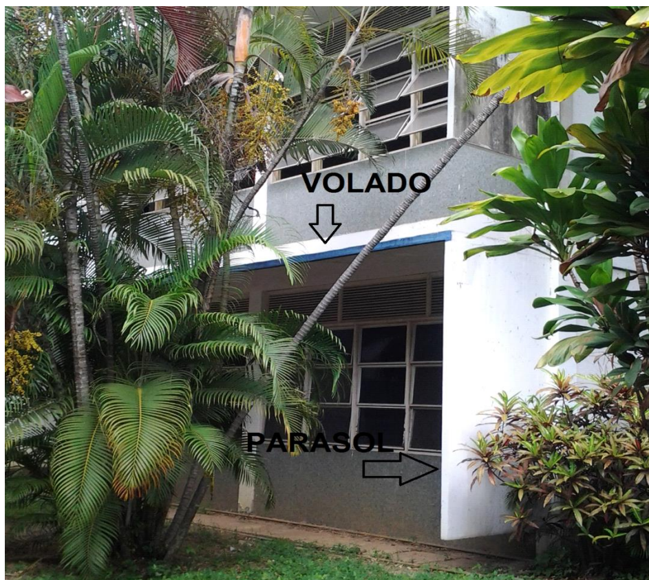
Figura 6.2 Volado y parasol existentes en el módulo 1. Fuente: Foto capturada el día 27 de abril de 2014
