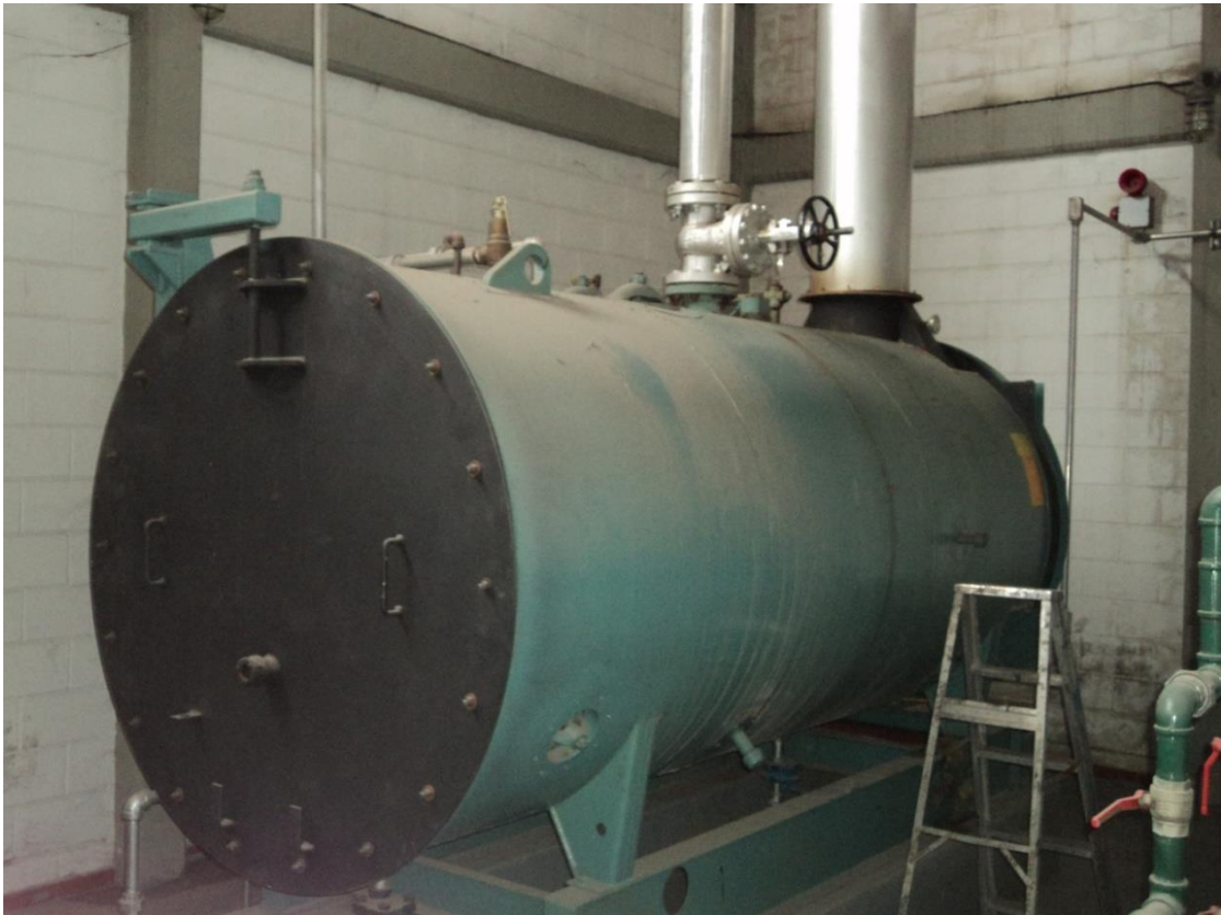
Figura 7. Caldera Pirotubular Marcar Cleaver Brooks. Modelo ICB 200- 100 -250. (Las Autoras, 2013)
