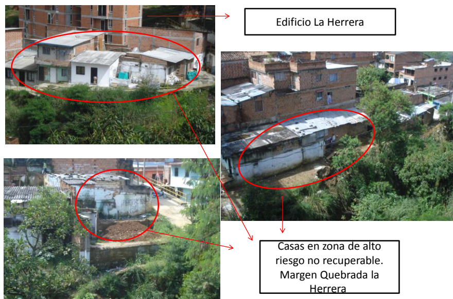
Fotos 34, 35, 36. Viviendas en zonas de riesgo.
