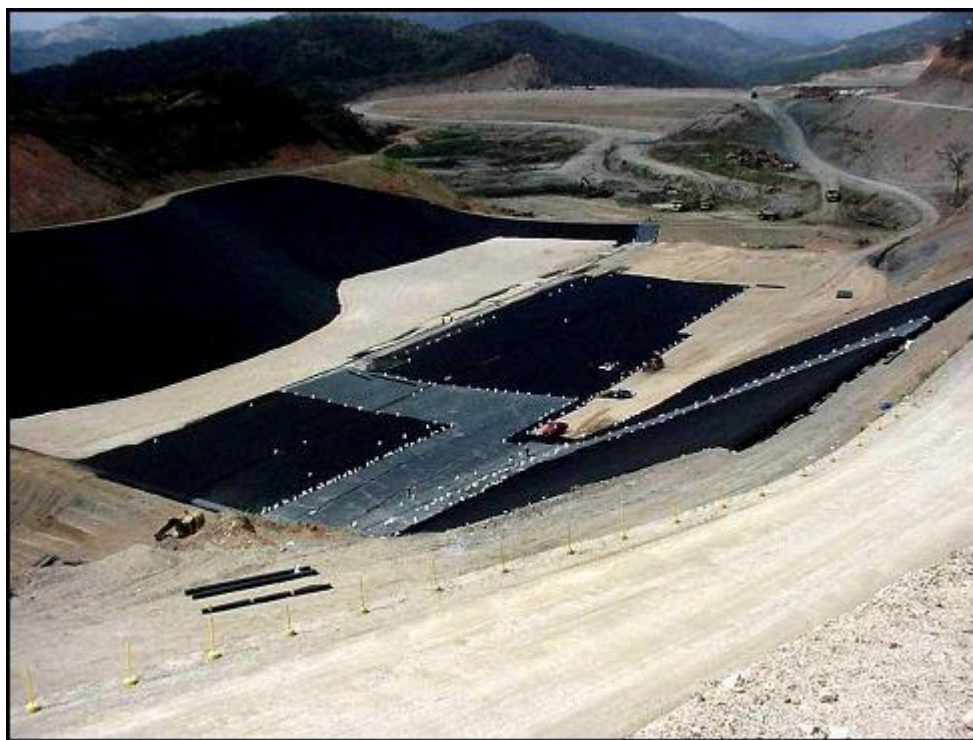
Figura 4.- Celda 1 durante el proceso de colocación del geosintético y la capa gravosa en el año de 1999 del relleno sanitario “La Bonanza” (Cotecnica, 2010).
