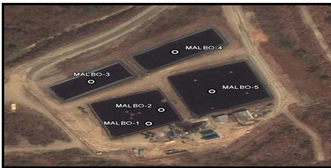
Figura 11.- Celdas de recolección de lixiviados del relleno sanitario "La Bonanza" (Google earth, 2010).
