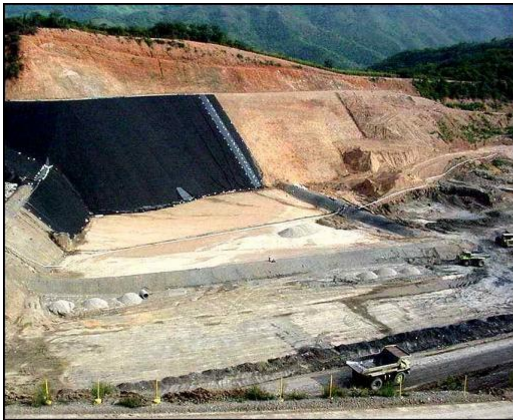
Figura 5.- Celda 2 durante el proceso constructivo inicial del relleno sanitario “La Bonanza” (Cotecnica, 2010).
