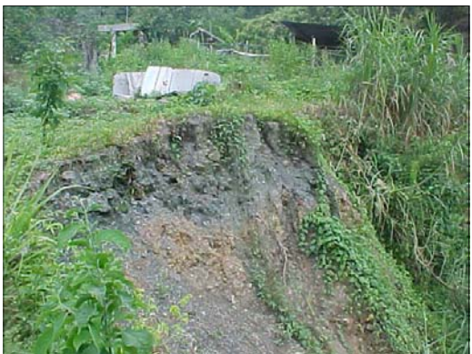
1.- Terreno inestable cercano al sistema de torrenteras de San Judas, el cual sigue avanzando pudiendo poner en peligro viviendas cercanas..
