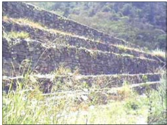
4.- Muro de gaviones de la Autopista Regional del Centro, cercano al Sector de San Judas Tadeo.
