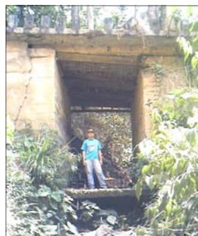
C.- Puente Tinta, es el paso de agua del sistemas de la torrenteras de San Judas hacia la Qda. Maitana y también recoge agua de la cuneta de la Carretera Nacional vía Paracotos
