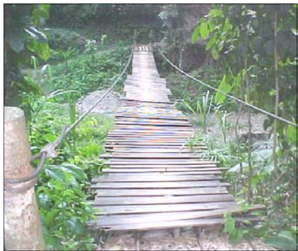
PASARELAS: Los sectores que se encuentran del otro lado de la Quebrada, tienen éste tipo de pasos para cuando la quebrada crece y no es posible cruzarla con facilidad.
