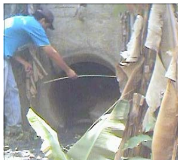
B.- Alcantarilla del Sector San Judas, a la izquierda salida a la torrentera que desemboca a la Qda. Maitana. A la derecha: deterioro de la tubería.
