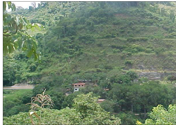
3. Talud de corte de la Autopista Regional del Centro, en el sector Los Mangos.
