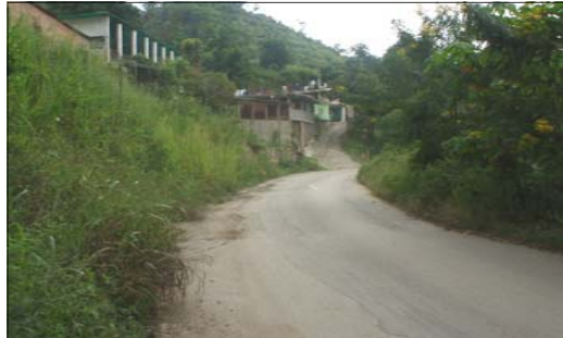
CARRETERA ASFALTADA: Existe una sola que atraviesa el sector y se le conoce con el nombre de Carretera Nacional vía Paracotos, a lo largo de la cual se ha desarrollado un alto porcentaje de la comunidad.
