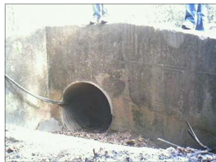
D.- Entrada de la alcantarilla Los Mangos 1
