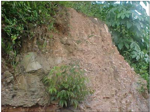
Suelo característico de la zona, el cual es producto de la meteorización de las rocas suprayacentes
