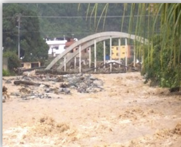
Foto N° 10: Puente colmatado, evento 2005
