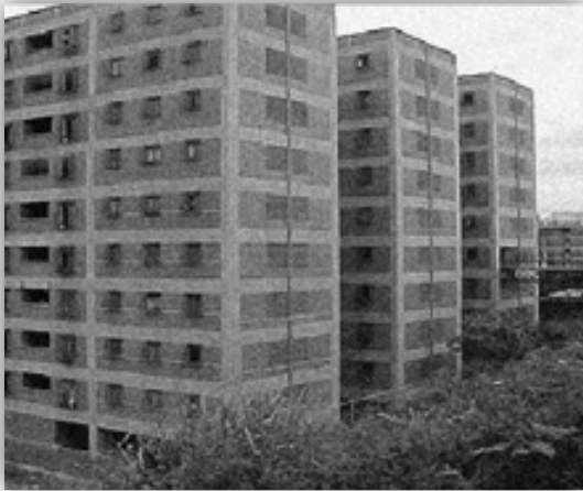
Foto N° 1 Edificios de sustitución de viviendas. Catuche Fuente: PNUD 2005a
