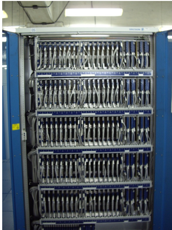
Figura 7: Sistema de puertos de entrada y salida IOG20.
