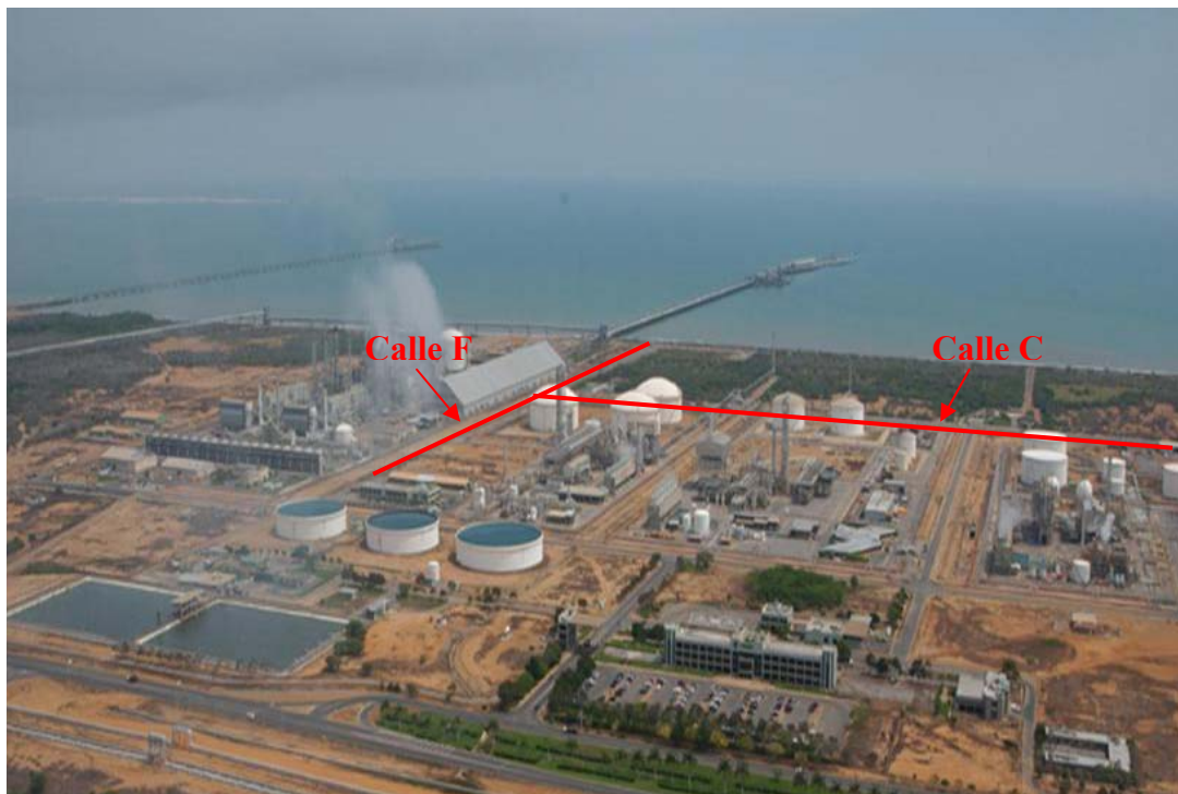
Figura 1: Vista parcial del Complejo Petroquímico General de División José Antonio Anzoátegui.
