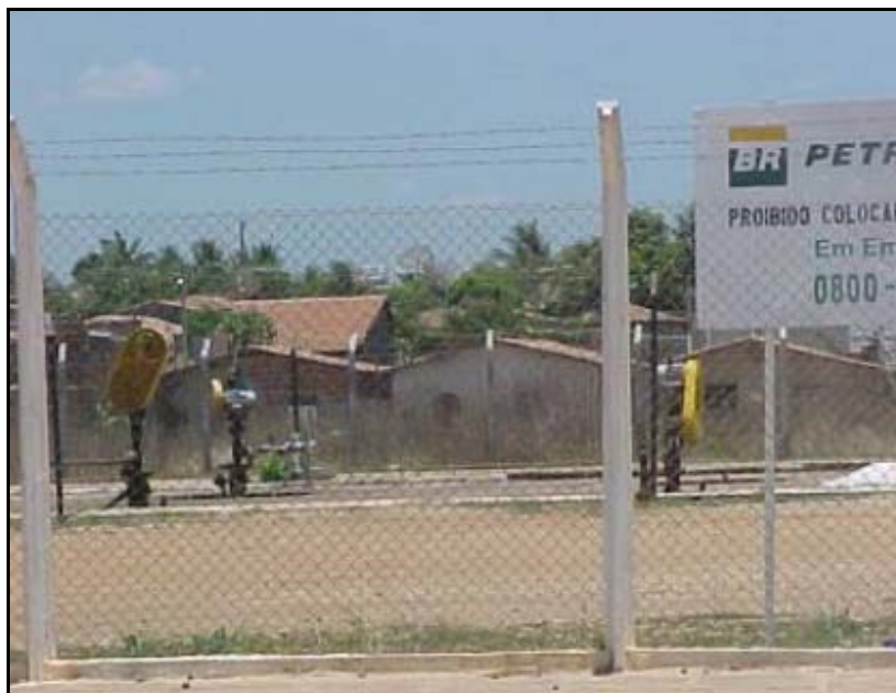
Fig. 3.- La poca cantidad de espacio requerido en superficie y el bajo nivel de ruido operacional generado por la BCP la convierte en una opción atractiva para su uso en zonas pobladas.
