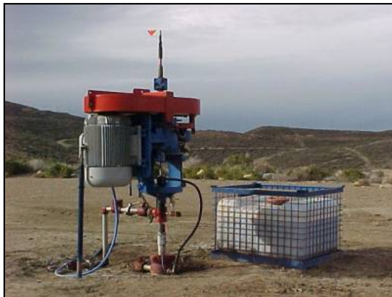
Fig. 2.- Esta es la estructura típica de superficie de un pozo que produce por BCP, el cabezal es un Weatherford M4.
