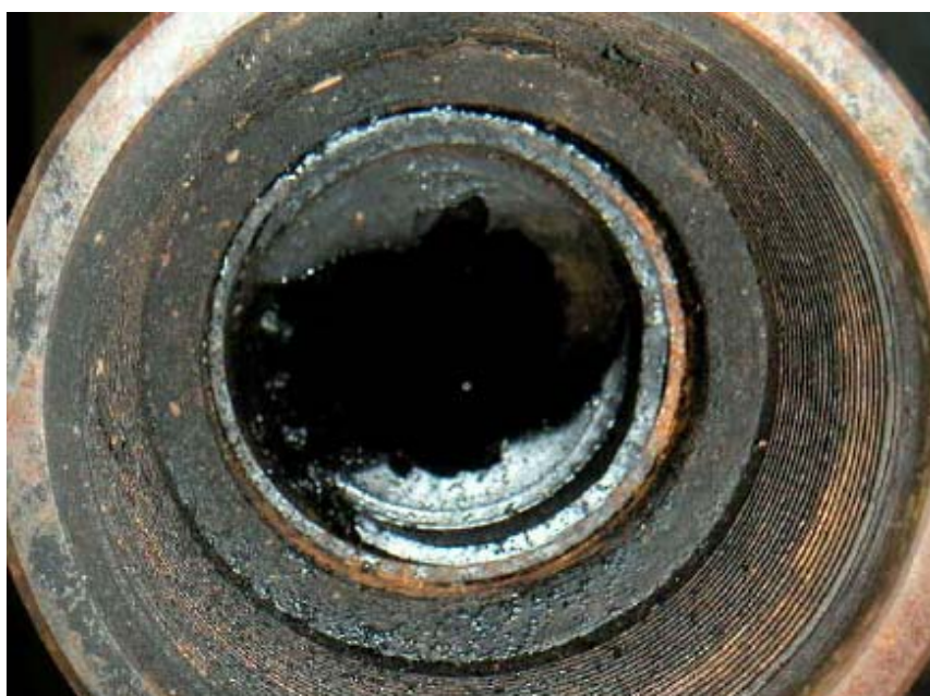
Fig. 40.- Elastómero desgarrado y desprendido de la base tubular, extremo de descarga. Pozo ES-452.
