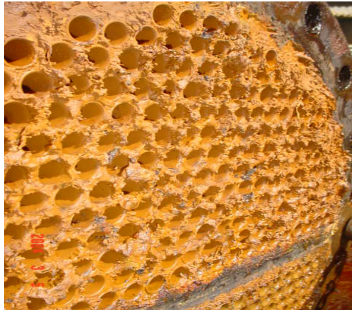
Figura 4. 3 Intercambiador de Calor
