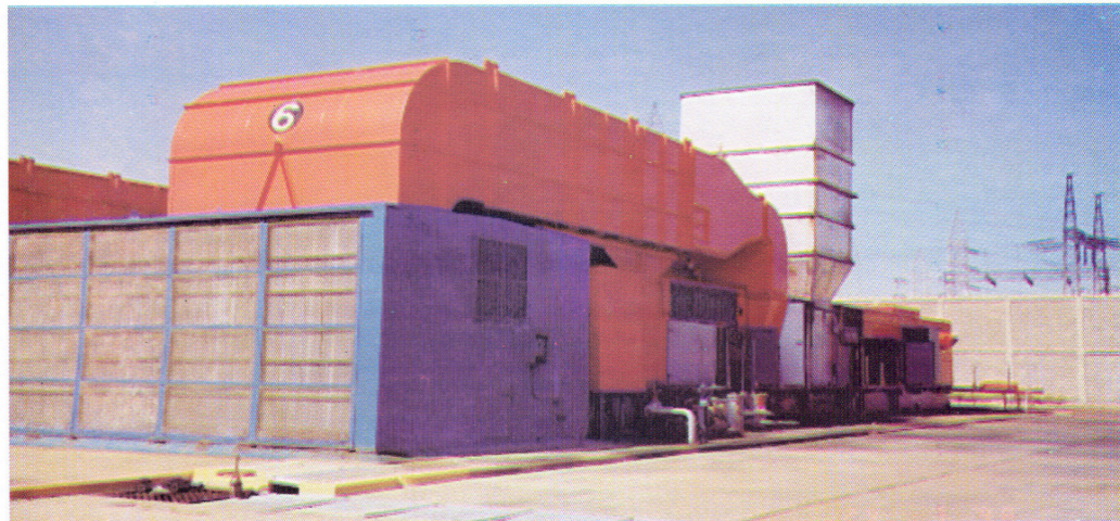
Figura 3. 3 Unidad turbo-generadora modelo MS-5001P (Manual de la turbina MS-5001P)
