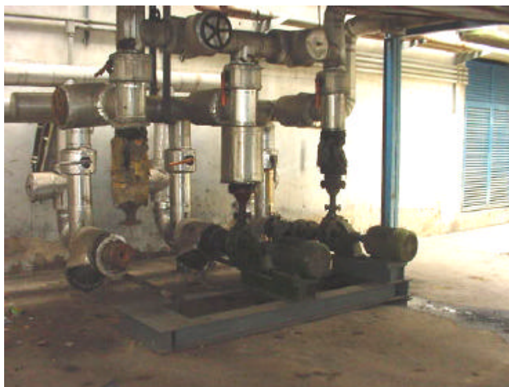
Figura 10. Sistema de Bombeo en Paralelo.
