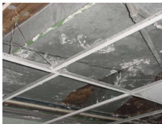
Figura 18. Tramo 2 de la Ductería de Extracción.
