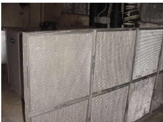
Figura 13. Filtros Seco de Celda o Panel Instalados en las UMA.
