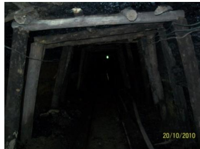
Figura N° 51. Sostenimiento galería de producción
