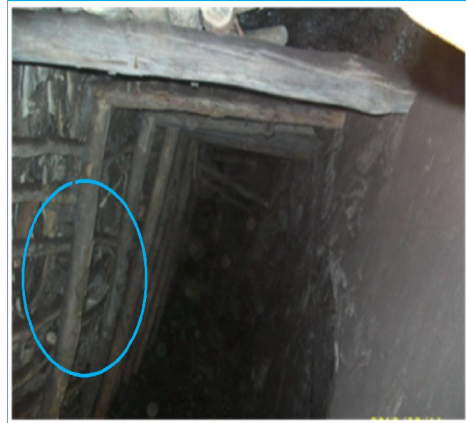
Pandeo de la Madera de Sostenimiento
