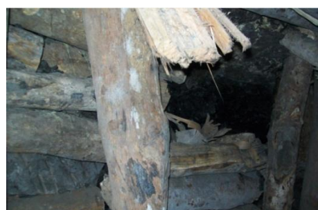
f) Relleno en la pared y sostenimiento partido
