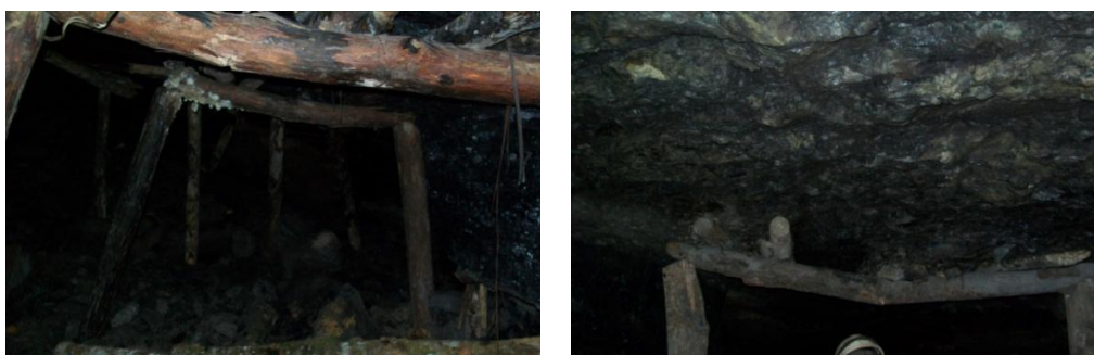
g) Pandeo de la madera de sostenimiento
