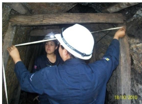
Figura N°56. Grafica durante el proceso de medición de la madera de sostenimiento
