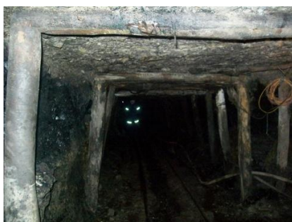
a) Sostenimiento de madera
