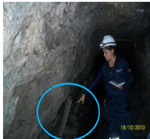
Figura N° 59. Estacas de madera de sostenimiento anterior.
