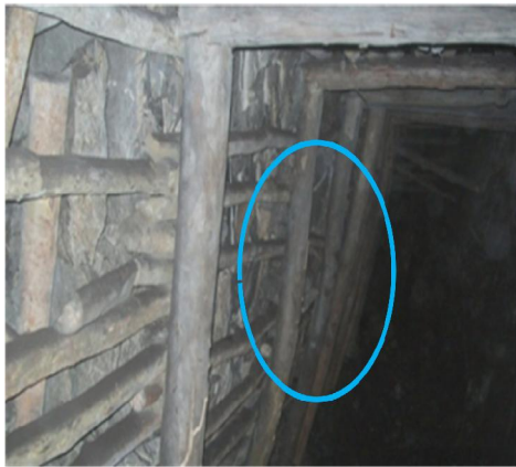
Pandeo de la Madera de Sostenimiento
