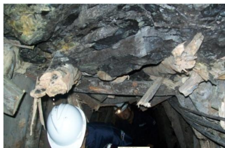
d) Material de Relleno entre techo y sostenimiento
