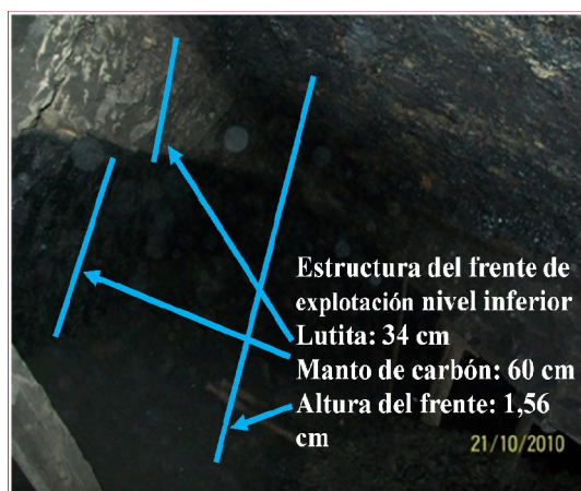
Figura N° 74. Estructura del frente de explotación nivel inferior
