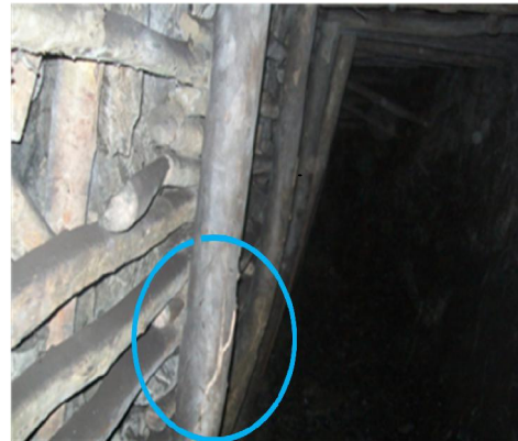
Madera Fracturada
