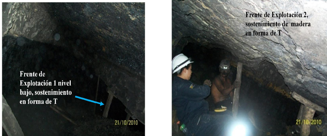
Figura N°73. Sostenimiento de madera en forma de T
