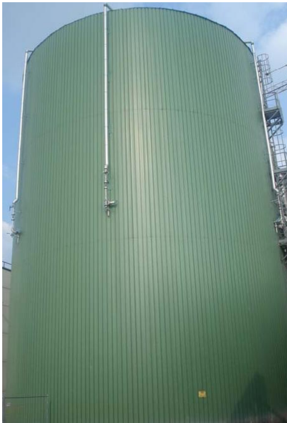
Figura 1.5: Digestore con lancia esterna
