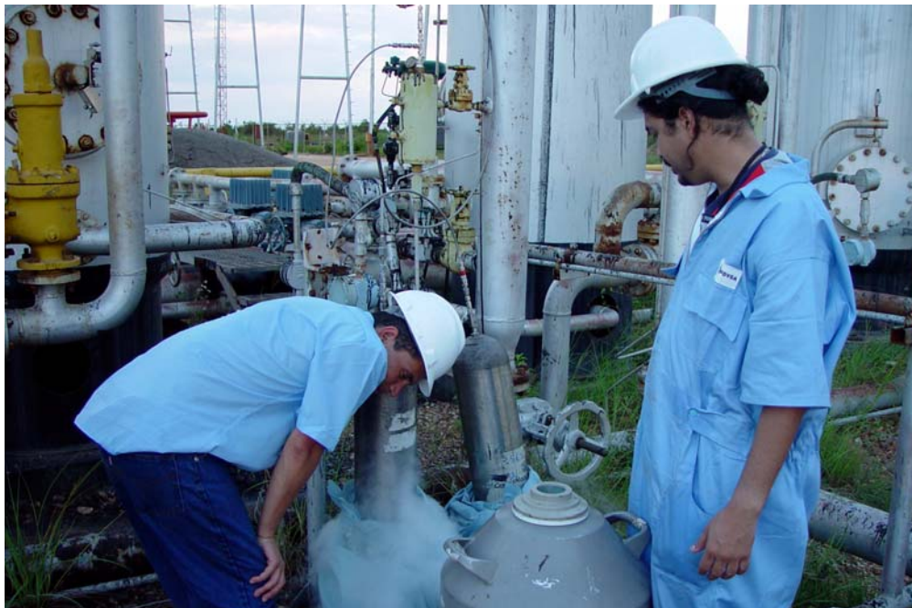
Figura 23. Toma de muestra en la estación de flujo para el pozo GC4.
