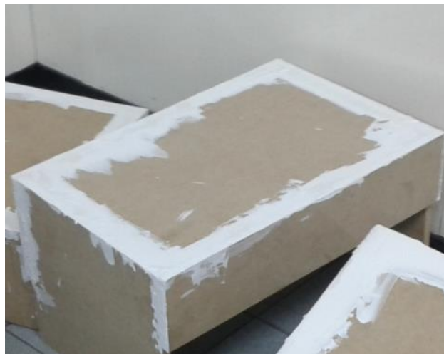
Fig. 3.0.5 Moldes con juntas selladas.
