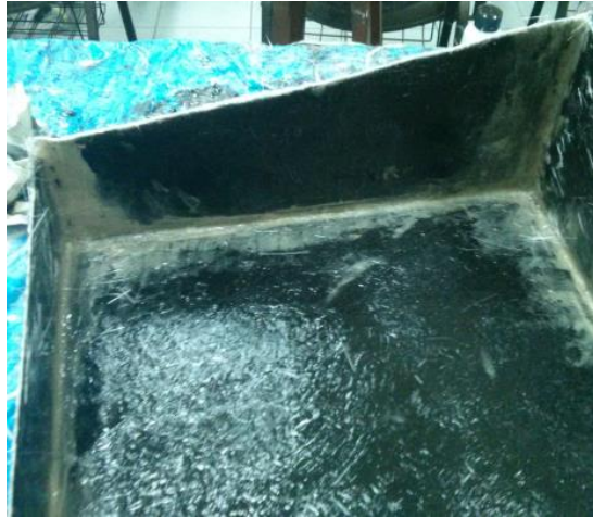
Fig. 3.0.10 Esquinas selladas con Talco Industrial malla 325.
