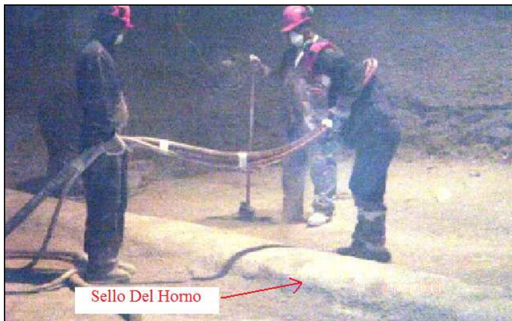
Fig. 5. 6: Sello Central del Horno de la Caldera Fuente: Suministrado por la EDC
