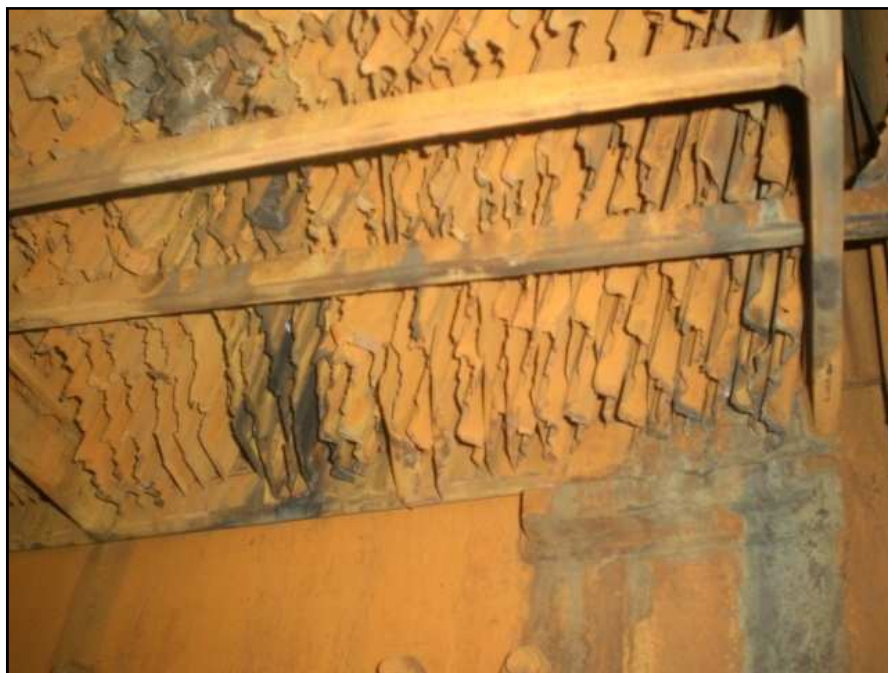
Fig. 5. 11: Superficies de transferencia de calor del Precalentador de Aire afectados por el uso de Residual N° 6 en la combustión Fuente: Planta Ampliación Tocoa
