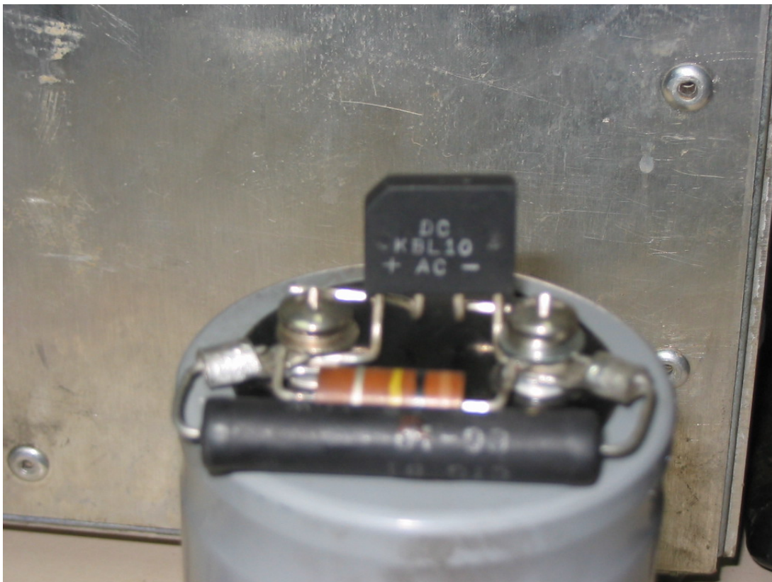
Figura 4.5. Construcción del filtro
