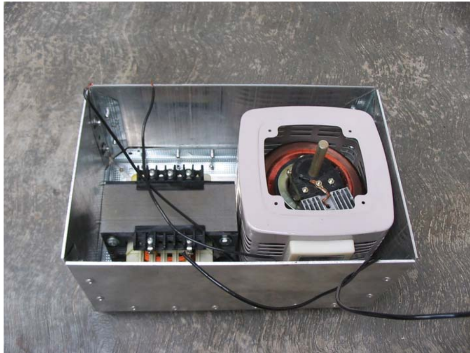
Figura 4.7. Instalación del variac y transformador
