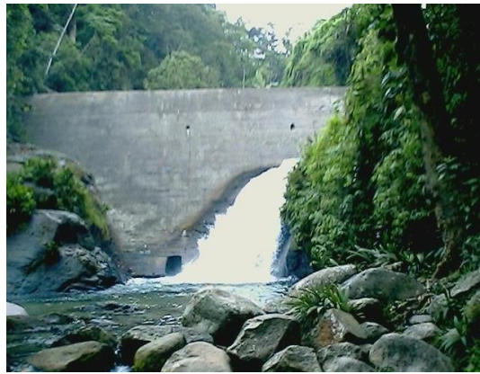
(9) El Dique en su parte baja (Uraca). (Fuente: Gordillo, Mar. 2005)
