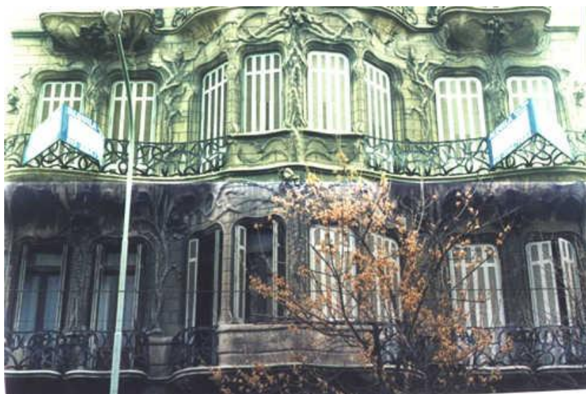
[Fig. 18] LA CASA DE LOS LÍRIOS,
