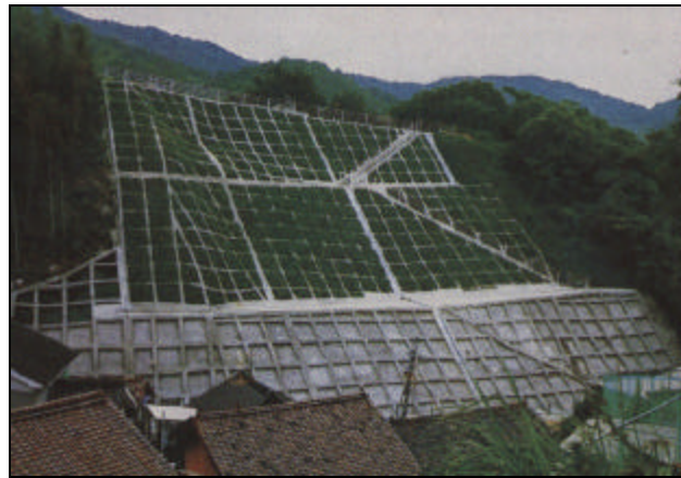
Fig. N° 54. Estabilización de laderas en Japón. (Tomado de VILLAR, 1993).
