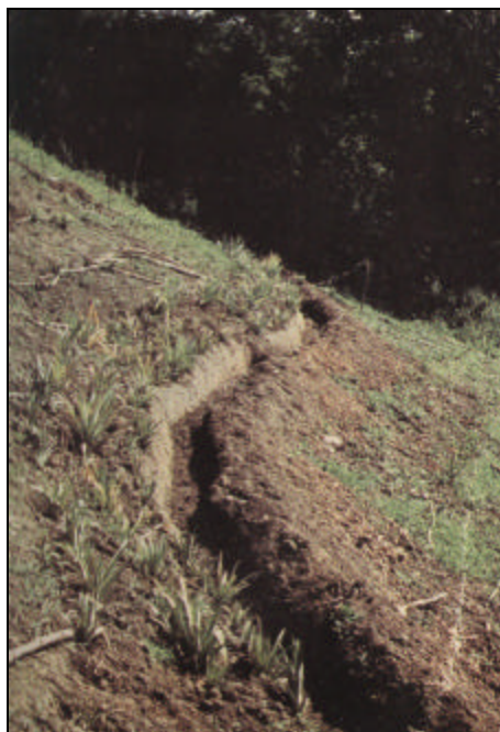
Fig. N° 51. Zanja interceptora de escurrimiento superficial en una ladera. (Tomado de VILLAR, 1993).
