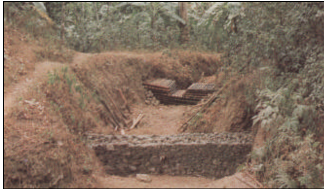
Fig. N° 56. Traviesas de mampostería y bambú, para el control de la erosión en cárcavas, Venezuela. (Tomado de VILLAR, 1993).
