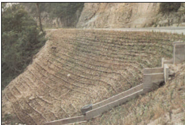
Fig. N° 49. Enfajinado y obras de drenaje para estabilizar un talud. (Tomado de VILLAR,1993).
