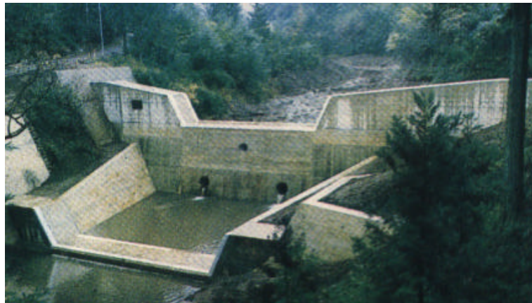
Fig. Nº 48. Disipadores de energía revestidos en concreto, presa en Japón. (Tomado de VILLAR, 1993).
