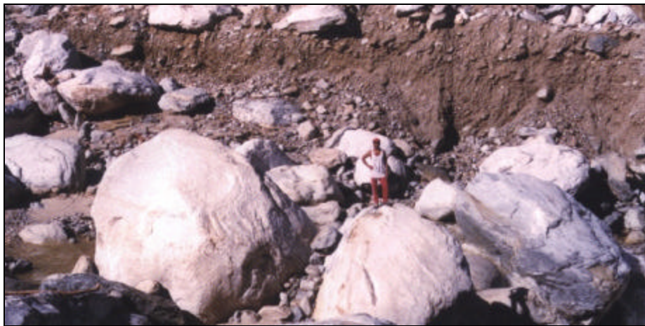
Fig. Nº 33. Escarpe producto de la socavación del río durante la creciente, Qda. San Julián. (Tomado de MUGUERZA 2001).
