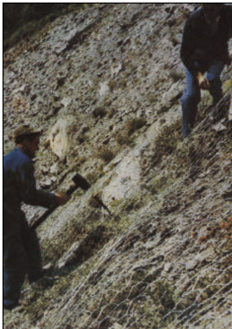
Fig. N° 52. Mallas ancladas, para evitar la caída de rocas. (Tomado de VILLAR, 1993).
