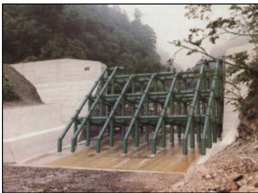
Vista desde aguas abajo.
