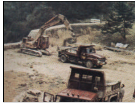
Excavación y remoción de los sedimentos.
