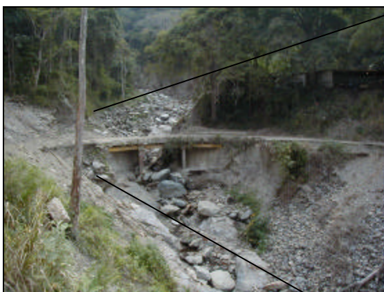
Fig. N° 36. Depósito típico de flujos torrenciales, obsérvese el mal escogimiento del material (bloques de roca y sedimentos granulares). Carretera vieja de La Guaira.
