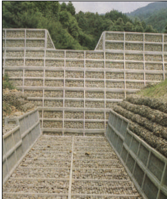
Fig. N° 70. Presa de malla de enrejado en Japón. (Tomado de VILLAR, 1993).
