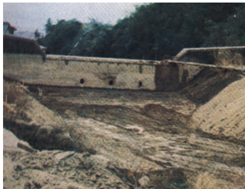
Fig. N° 59. Remoción de sedimentos en la presa Nagamine, Japón. (Tomado de VILLAR, 1993).
