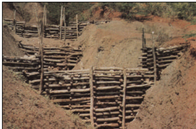
Fig. N° 57. Traviesas formadas por celdas de troncos rellenas de piedras en el control de cárcavas, Venezuela. (Tomado de VILLAR, 1993).
