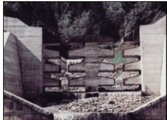
Presa con combinación de ranuras y ventanas en Austria. Las aristas se encuentran protegidas del desgaste con ángulos de acero.
