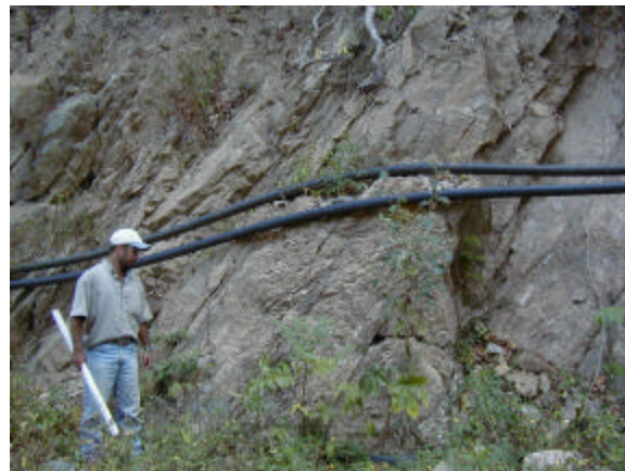
Fig. N° 44. Tomas de agua Improvisadas. Mangueras que transportan agua, las mismas son colocadas de forma inadecuada, presentando con frecuencia botes que erosionan el suelo y producen la infiltración del agua. Qda. San Julián. (Tomada de INGEOEC, 2000).
