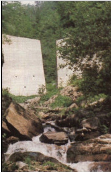
Fig. N° 62. Presas con ranuras de paredes inclinadas en Austria. (Tomado de VILLAR, 1993).
