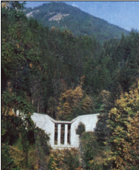
Presas con ventanas rectangulares en Austria.
