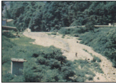
Presa colmatada, antes de la remoción de los sedimentos.
