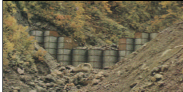
Presas de celdas metálicas en Japón.
