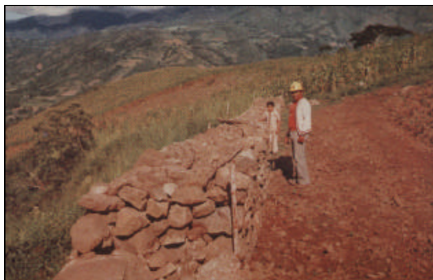
Fig. N° 55. Muros de piedra, para interceptar el escurrimiento superficial y evitar la erosión de los suelos, Andes Venezolanos. (Tomado de VILLAR, 1993).
