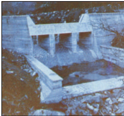
Presa con ventanas cuadradas en España.
