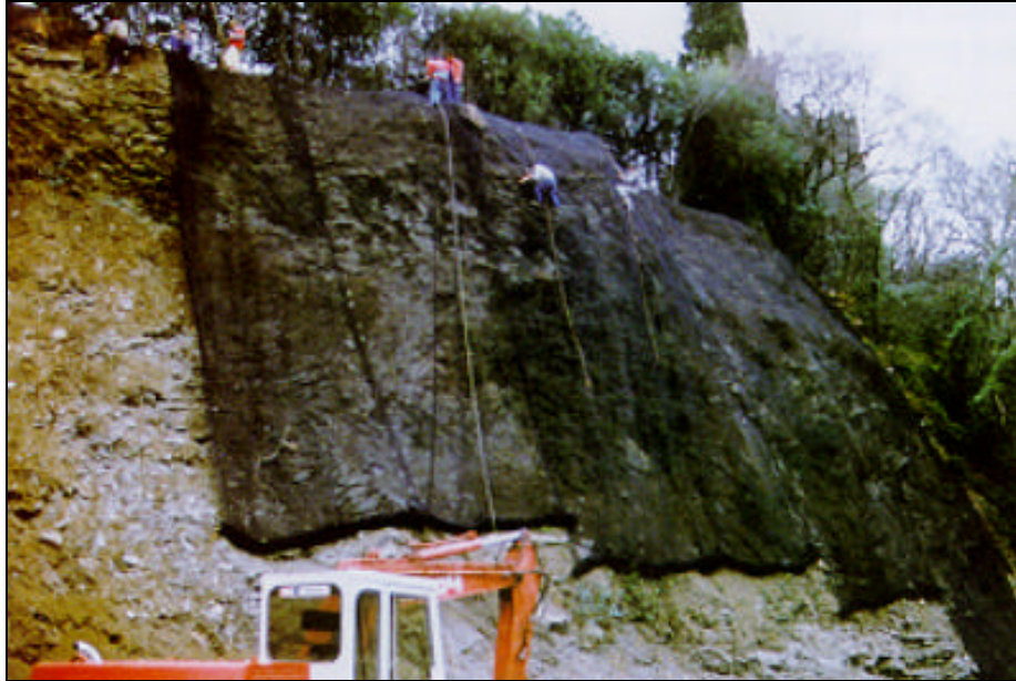
Fig. N° 47. Protección contra la erosión y desprendimiento de bloques de roca y suelo. (Tomado de Macaferri, 2002).
