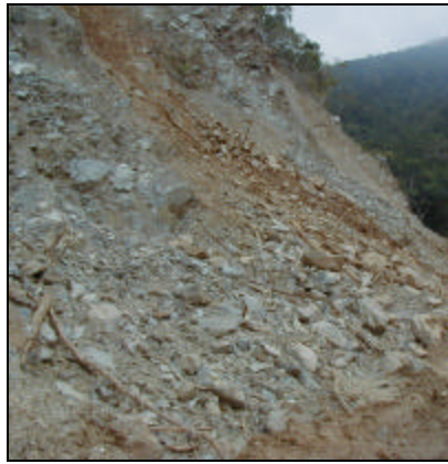
Fig. N° 41. Talud de corte deteriorado. Carretera vieja de la Guaira.
