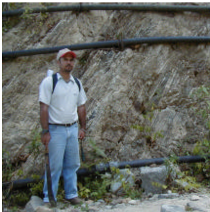
Fig. N° 44. Tomas de agua Improvisadas. Mangueras que transportan agua, las mismas son colocadas de forma inadecuada, presentando con frecuencia botes que erosionan el suelo y producen la infiltración del agua. Qda. San Julián. (Tomada de INGEOEC, 2000).
