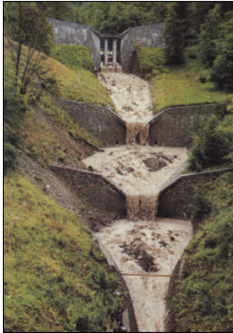
Fig. N° 64. Presa superior abierta, seguida de una serie de presas tradicionales escalonadas a lo largo del torrente, Austria. (Tomado de VILLAR, 1993).
