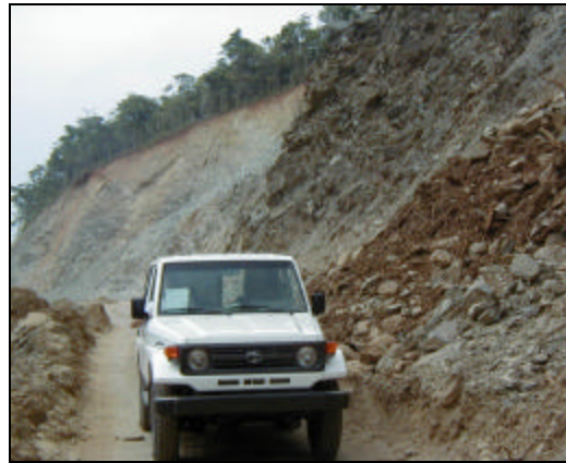
Fig. N° 41. Talud de corte deteriorado. Carretera vieja de la Guaira.
