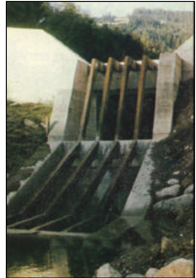
Fig. N° 67. Presas con rejas metálicas aguas arriba, Austria. (Tomado de VILLAR, 1993).
