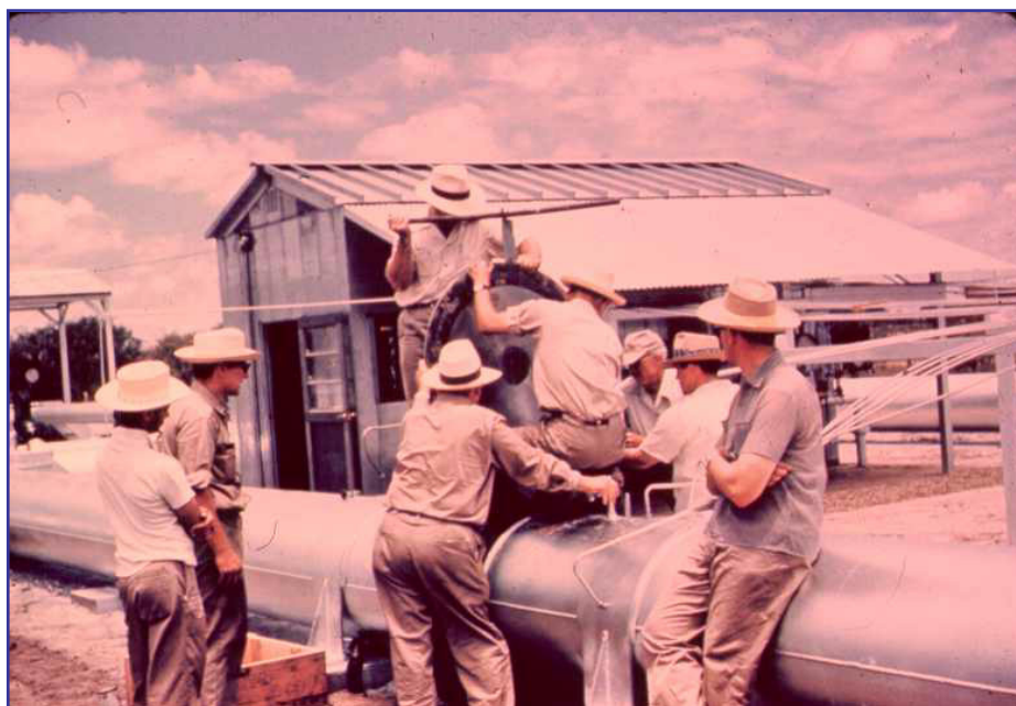
Figura 3.1: Instalación de placa orificio (23)
