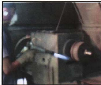
Figura 4.1. Aplicación del Termorrociado
