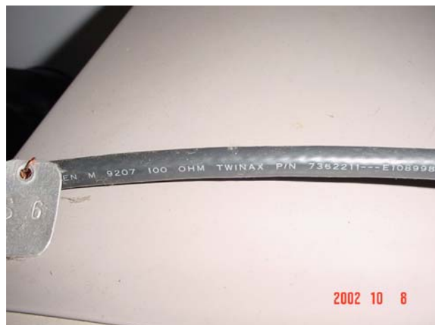
Fig. 4 Cable Twinaxial instalado
