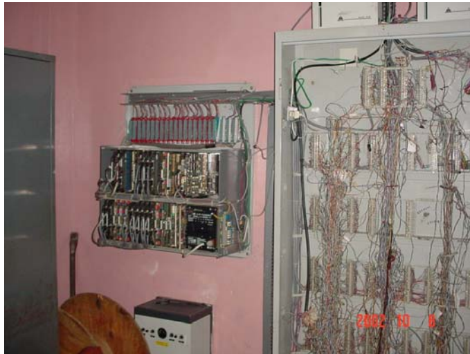
Fig. 6 Vista Central Telefonica y FXB Edf, Administrativo
