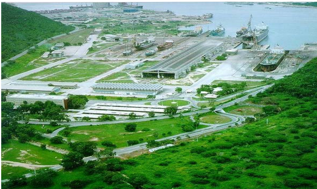
Figura 1 Vista Complejo DIANCA –Puerto Cabello- Estado Carabobo
