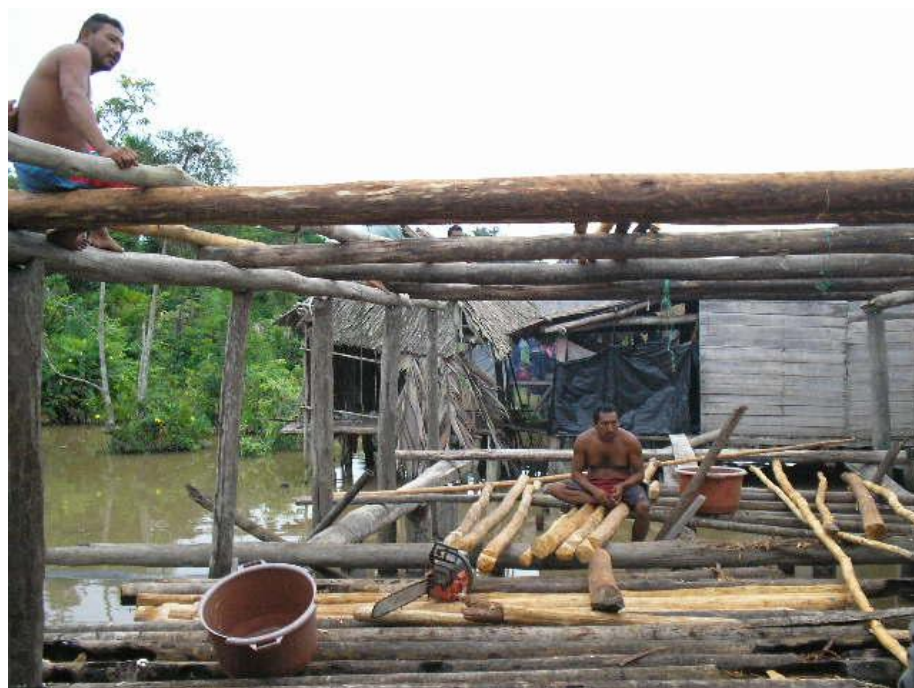
Figura N° 21: Hombres Warao Construyendo Palafito
