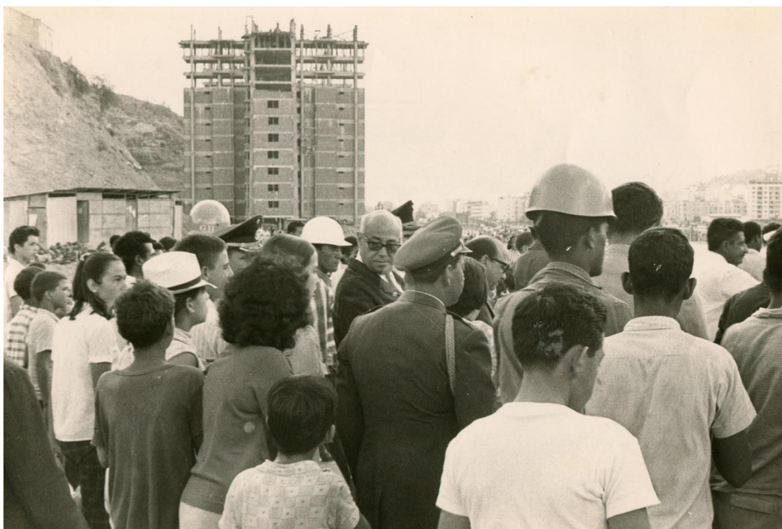
Anexo 18: parroquia El Valle Obras en Barrios de Caracas periodo de Raúl Leoni Colección OCI.
