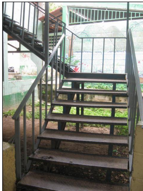
Figura 7.1.6 Escalera 1 vista desde abajo, ubicada entre ejes 2 y 3 Fuente: Los Autores
