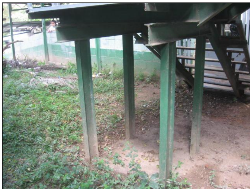
Figura 7.1.7 Columnas base del módulo de escalera 1
