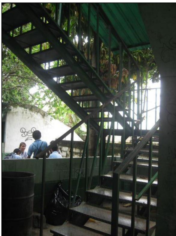
Figura 7.1.8 Módulo de escalera 2, ubicada entre ejes 11 y 12
