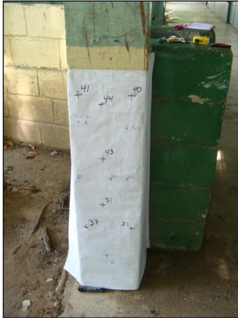
Figura 7.1.25 Disposición del acero de refuerzo en la columna A-8 Fuente: Los Autores
