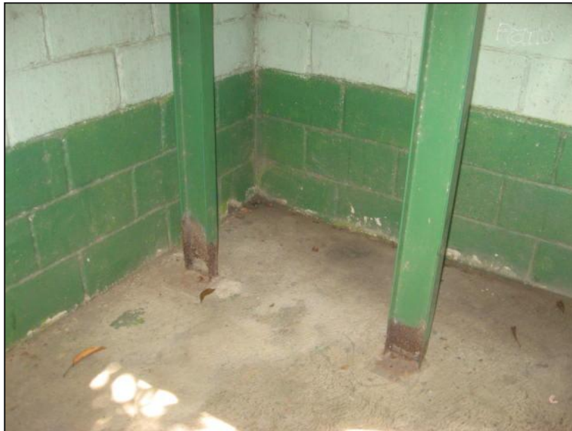
Figura 7.1.10 Dos columnas de apoyo del módulo de escalera 2.
