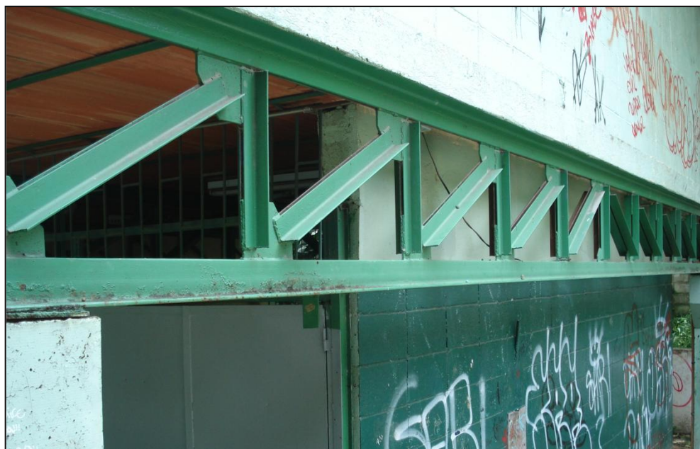
Figura 7.1.11 Cercha típica de la estructura
