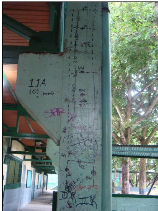
Figura 7.1.26 Disposición del acero de refuerzo en la columna A-11 Fuente: Los Autores
