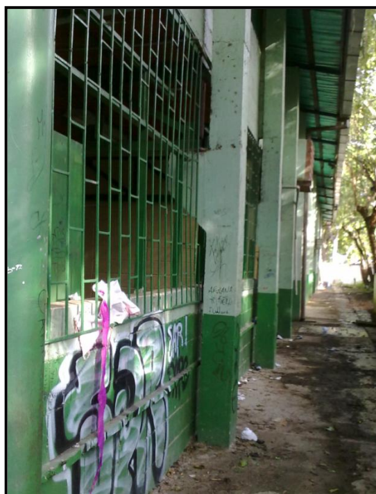
Figura 7.1.1 Fachada posterior del edificio
