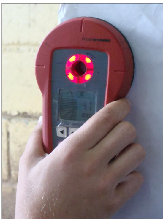
Figura 7.1.22 Ferroskan utilizado en la detección de acero en las columnas
