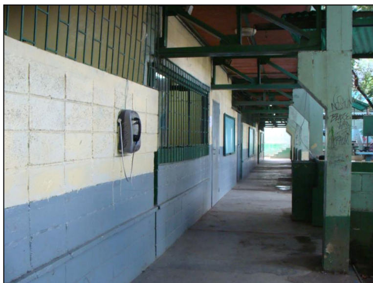
Figura 7.1.2 Fachada principal en planta baja
