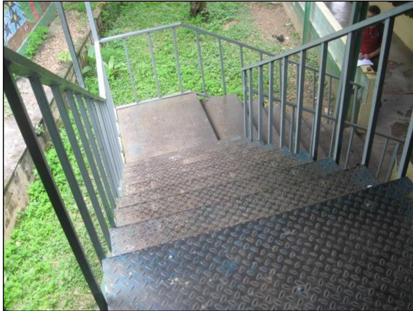
Figura 7.1.5 Escalera 1 vista desde arriba, ubicada entre ejes 2 y 3 Fuente: Los Autores
