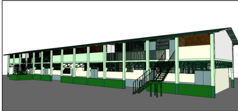
Figura 5.3.1 Fachada principal de la edificación (Este-Oeste).
