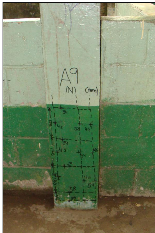
Figura 7.1.24 Disposición del acero de refuerzo en la columna A-9. Fuente: Los Autores
