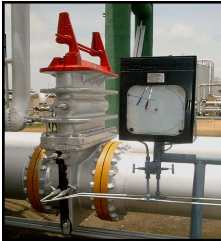
Figura II.24 Medición con Placa Orificio del Complejo Jusepín. (Hernández, 2012)
