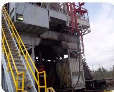
Figura 13 – Subestructura del taladro [Aristimuño y Briceño, 2012]
