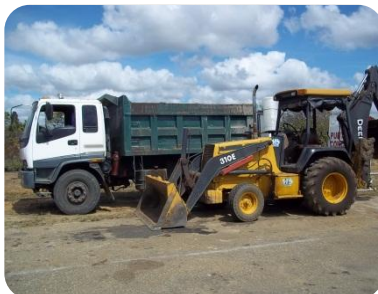
Figura 58 - Volteo y retroexcavadora [Aristimuño y Briceño, 2012]
