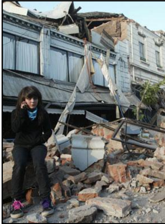
Figura II.18 Daños en edificaciones tras terremoto de febrero de 2010. Chile.
