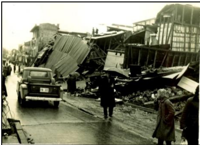
Figura II.17 Colapso de edificaciones tras terremoto de 1960. Chile.
