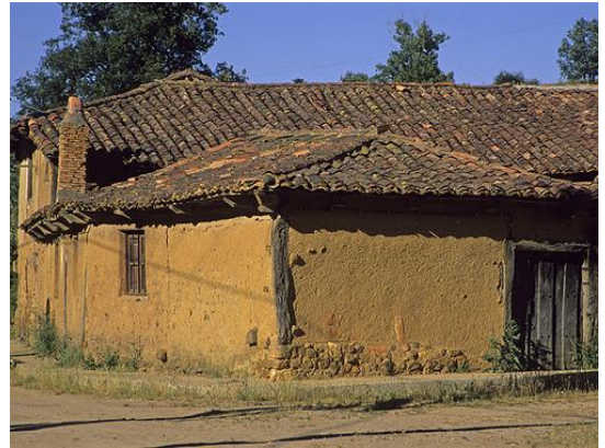
Figura 5 Muro de Adobe Tomado de Ref. 21
