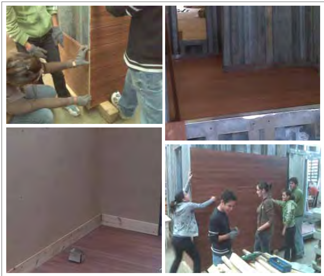
Figura. 131 Montaje de los acabados del Módulo A. Fuente: Propia. 2010
