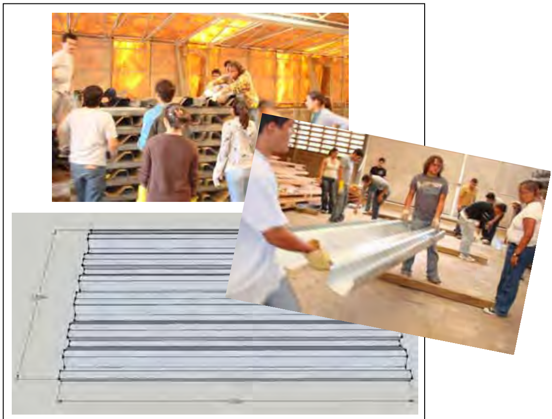
Figura. 123 Laboratorios del Laurel. Ensamblaje del piso. Fuente: Propia 2010
