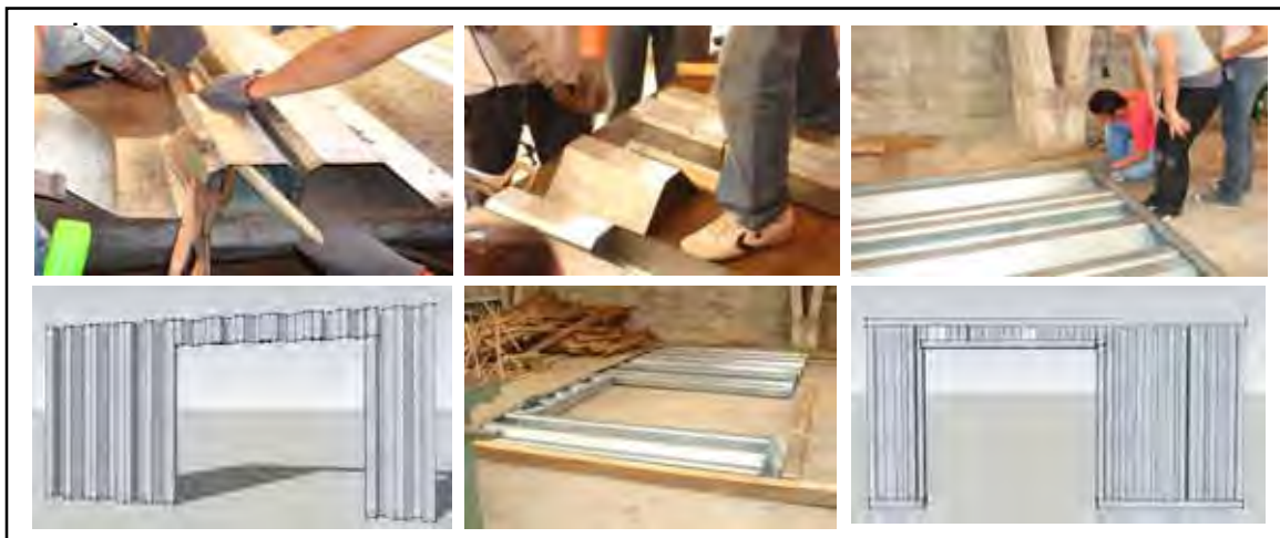
Figura. 127 Laboratorios del Laurel. Ensamblaje de las paredes. Fuente: Propia 2010
