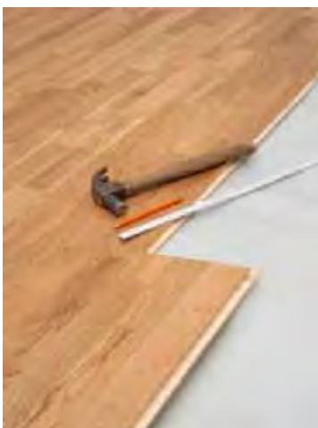
Figura. 191. Montaje del piso. Fuente: http://es.drevdom.com 2011
