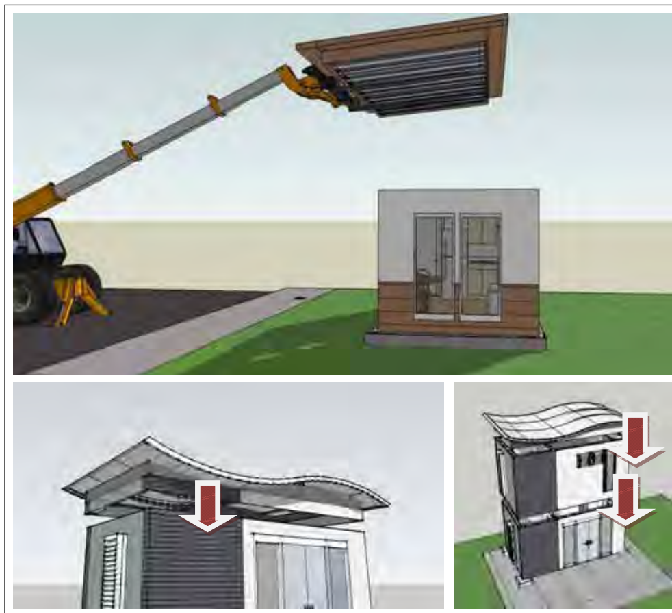
Figura. 101 Colocación del techo u otro módulo en sitio.
