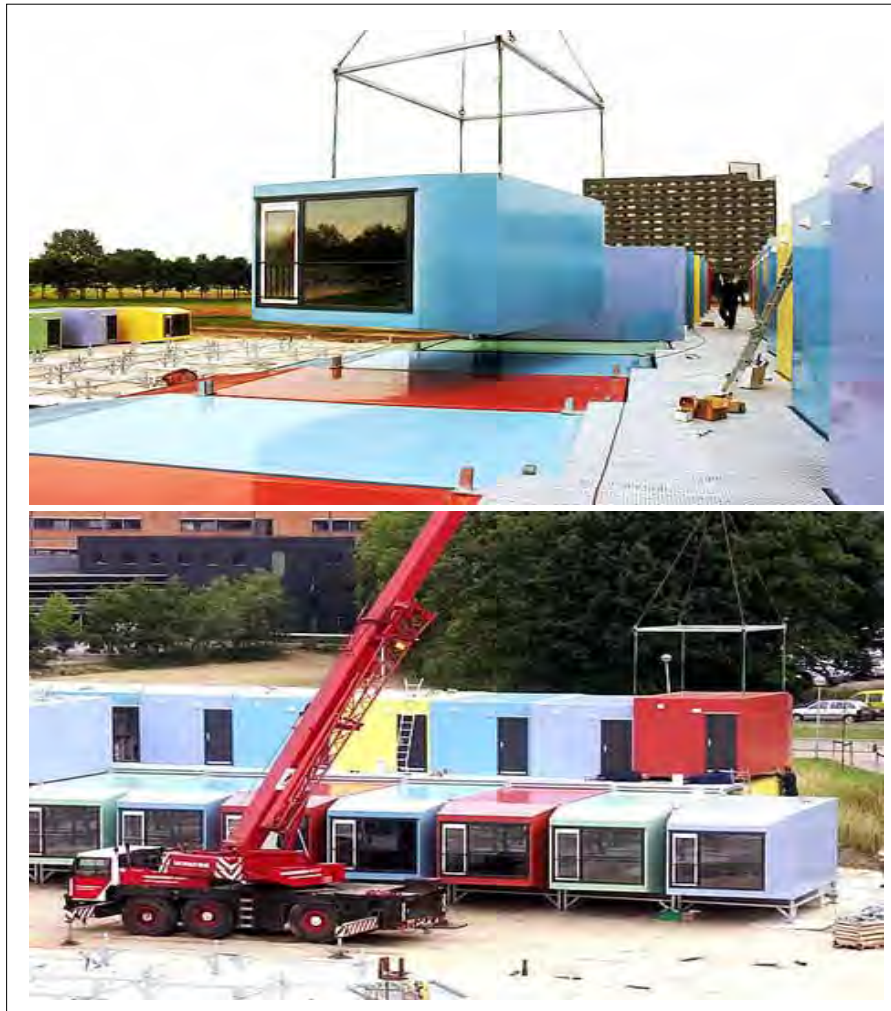
Figura. 13 Montaje de los módulos de vivienda. Fuente: http://www.spacebox.nl/ . 2007
