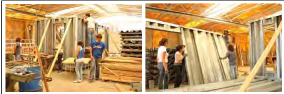
Figura. 128 Ensamblaje de las paredes del Módulo A.
