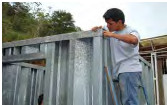
Figura. 114 Desmontaje. Fuente: Fotos Propias. 2010
