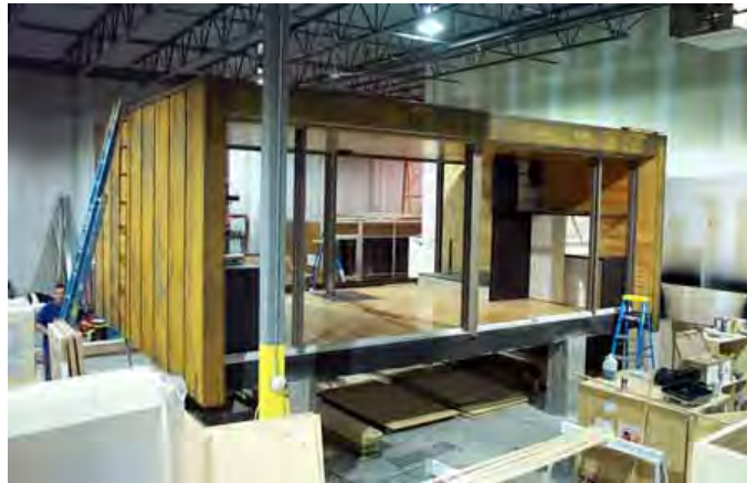
Figura. 14 Construcción de una vivienda WeeHouse Fuente: http://tinyhouseblog.com/pre-fab/weehouse/ . 2008
