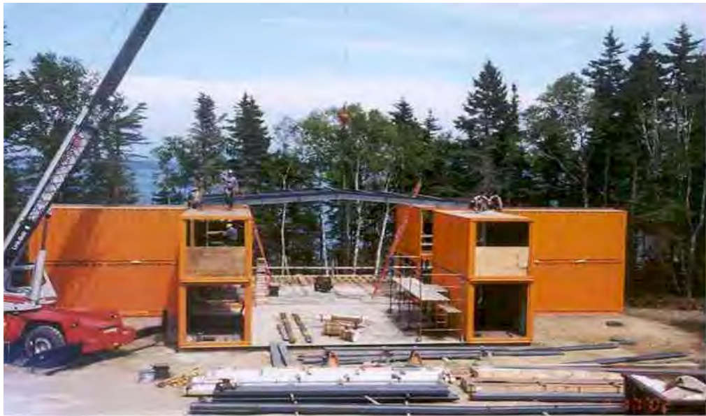
Figura. 24 Construcción de la 12 Container House de A. Kalkin. Fuente: www.architectureandhygiene.com/main.html .2008
