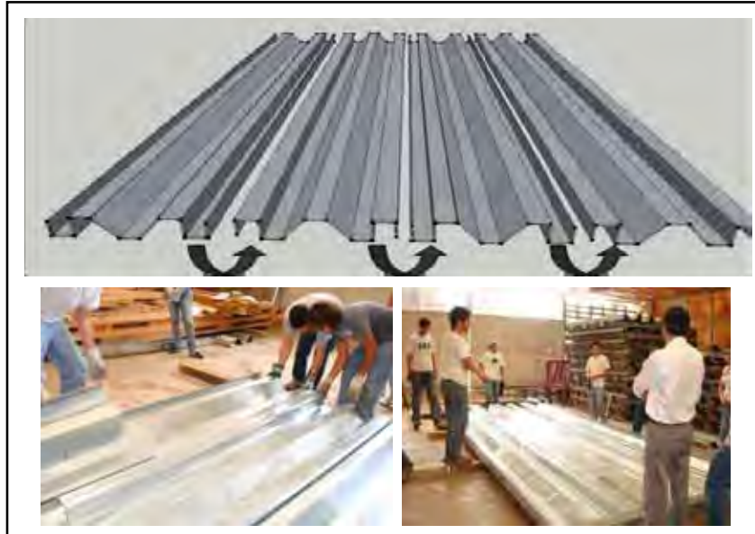
Figura. 124 Laboratorios del Laurel. Ensamblaje del piso. Fuente: Propia 2010
