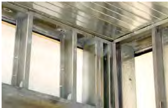
Figura. 113 Marcos metálicos. Fuente: http://www.bricopage.com . 2012
