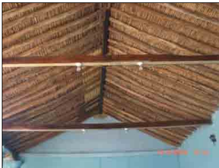
Figura N° 69. Techo del Salón de Banquetes del Templo Masónico de Barcelona (Foto: Jipson Briceño, 2009).
