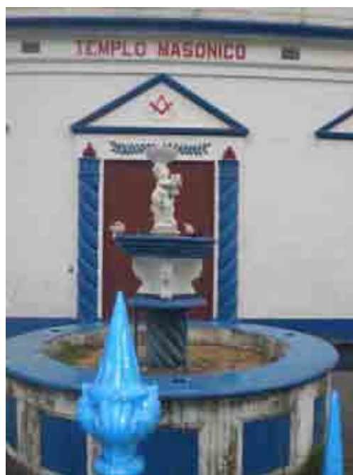
Figura N° 102. Fachada del Templo Masónico de San Fernando de Apure. Detalle de la portada ciega del Templo (Foto: Jipson Briceño, 2011).
