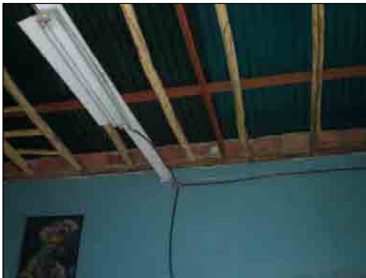
Figura N° 107. Techo del Templo Masónico de San Fernando de Apure (Foto: Jipson Briceño, 2011).
