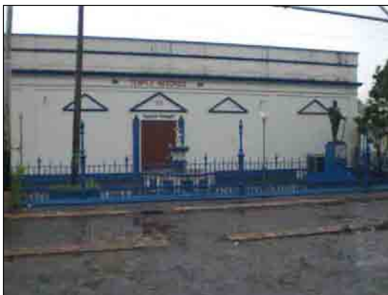
Figura N° 100. Fachada frontal del Templo Masónico de San Fernando de Apure (Foto: Jipson Briceño. 2011).
