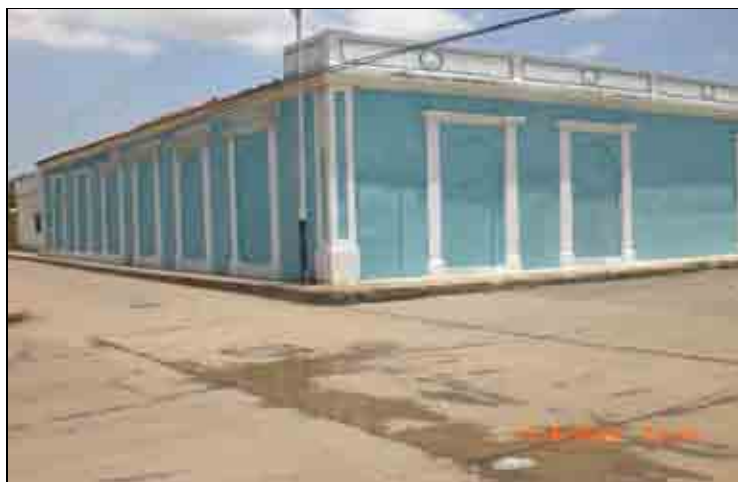
Figura N° 74. Fachada lateral del Templo Masónico de Barcelona (Foto: Jipson Briceño, 2009).
