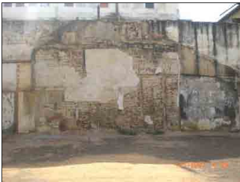
Figura N° 118. Espacio donde se encontraba la Camara Principal, notese lo reducido de los espacios laterales (Foto: Jipson Briceño, 2010).
