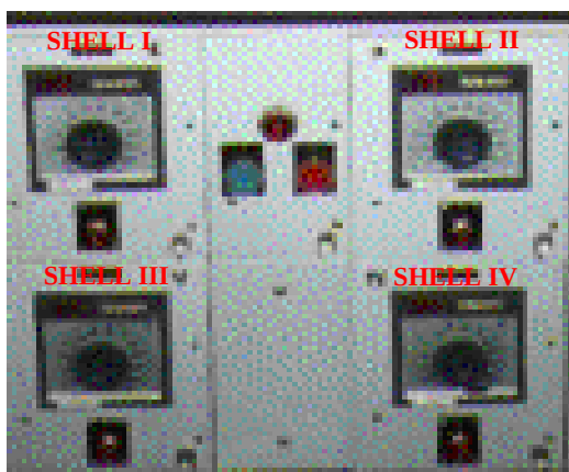
Figura N° 23: Panel de control de la Planta
