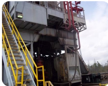
Figura 13 – Subestructura del taladro [Aristimuño y Briceño, 2012]
