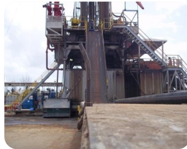
Figura 15 - Rampa de tubería [Aristimuño y Briceño, 2012]
