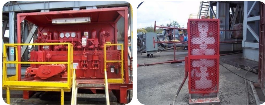
Figura 76 - Unidad acumuladora [Aristimuño y Briceño, 2012]
