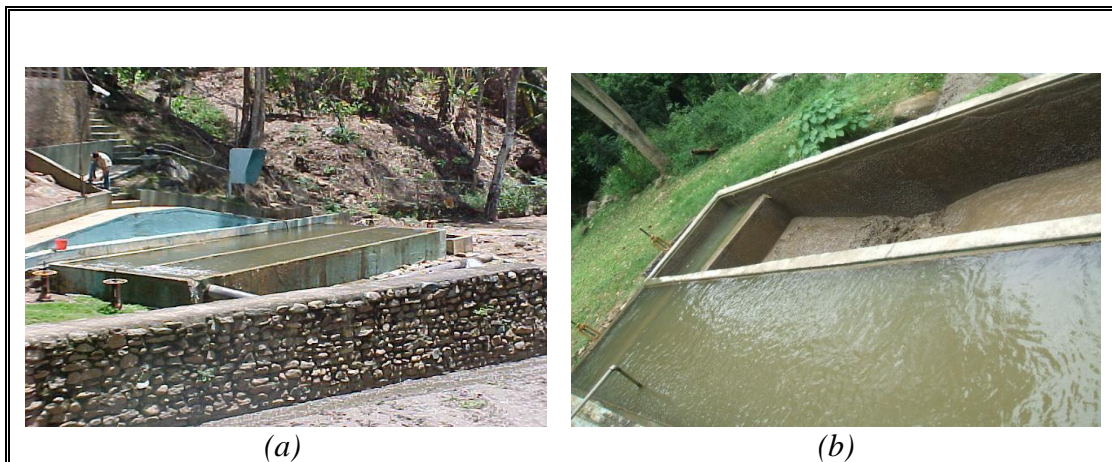
Figura IV.2. (a y b). Desarenadores del río Curtidor.
