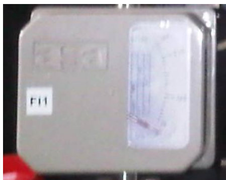
Apéndice A. 19: Fotografía del Medidor De Flujo De Agua De Enfriamiento de la UDCA.
