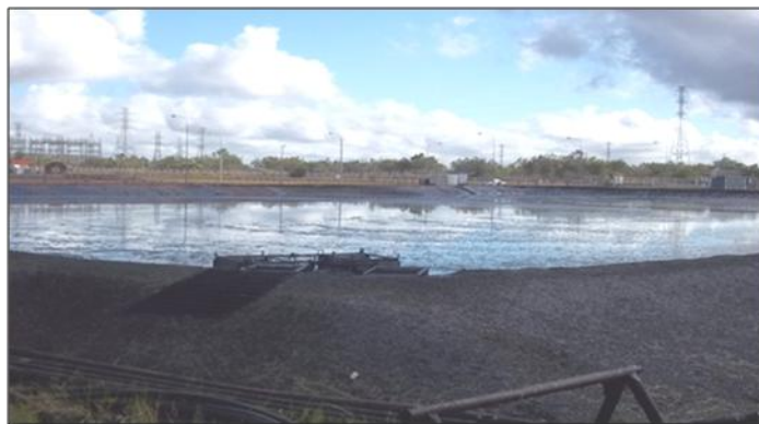
Figura N° 4. Fosa de Producción ubicada en el Centro Operativo Bare (C.O.B)- PDVSA PETROPIAR. El Tigre, Estado Anzoátegui.
