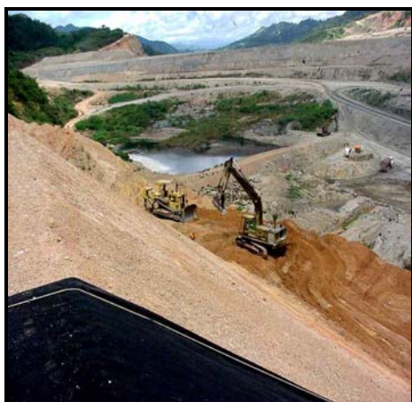
Fig. 34. Perfilado del Talud
