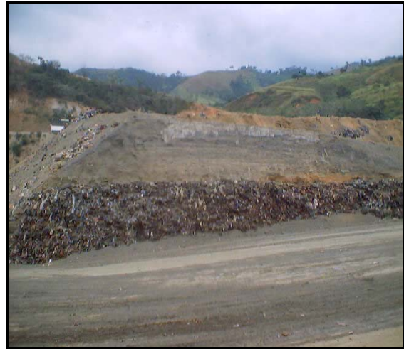
Fig. 55. Talud de Basura con Sobrecarga Adicional
