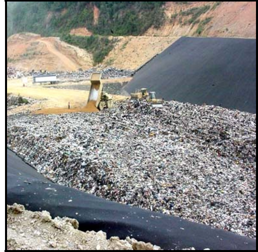
Fig. 43. Colocación de la Capa de Recubrimiento
