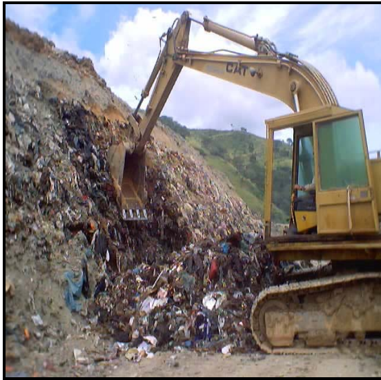
Fig. 45. Perfilado del Talud de Basura con Sobrecarga Inicial
