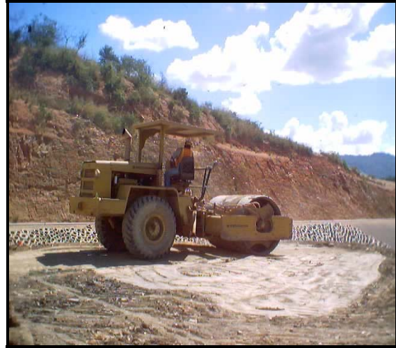
Fig. 53. Compactación de la Sobrecarga Adicional
