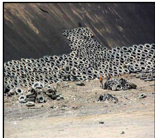
Fig. 39. Colocación de Cauchos para la Protección de la Geomembrana
