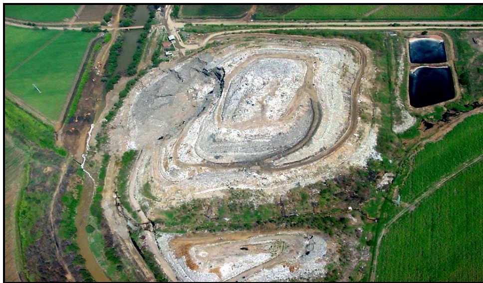
ANEXO B - 2. Vista Aérea de una Falla Circular de un Talud de Basura en el Relleno Sanitario “Navaro” en Cali, Colombia
