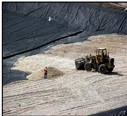
Fig. 38. Colocación de Capa de Grava
