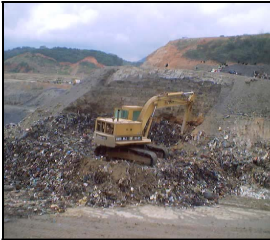
Fig. 54. Perfilado del Talud de Basura con Sobrecarga Adicional
