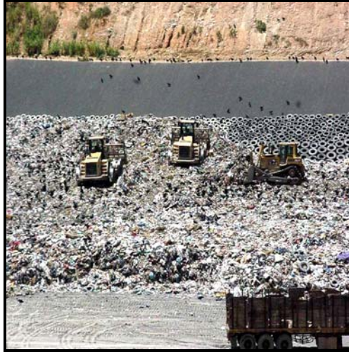
Fig. 42. Esparcimiento y Compactación de Residuos Sólidos
