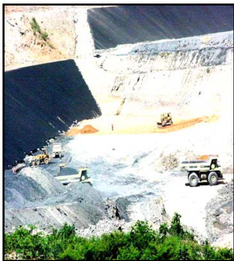
Fig. 36. Compactación de las Capas de Arcilla
