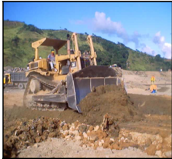
Fig. 51. Esparcimiento del Material de Préstamo
