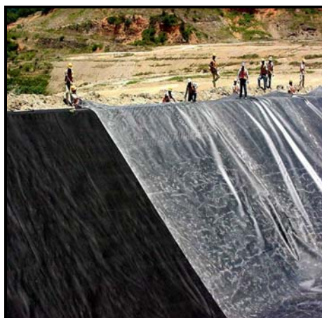
Fig. 35. Colocación de la Geomembrana y Geotéxtil en el Talud
