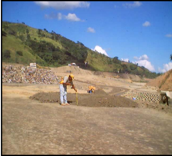
Fig. 52. Control del Espesor de la Capa de Tierra
