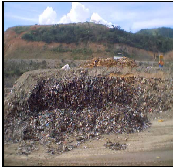
Fig. 46. Talud de Basura Perfilado con Sobrecarga Inicial
