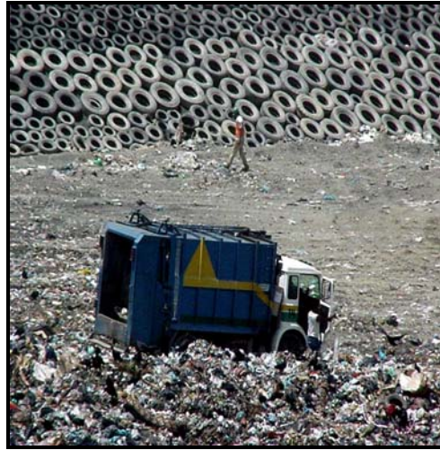
Fig. 40. Descarga de Residuos Sólidos Directamente en la Celda
