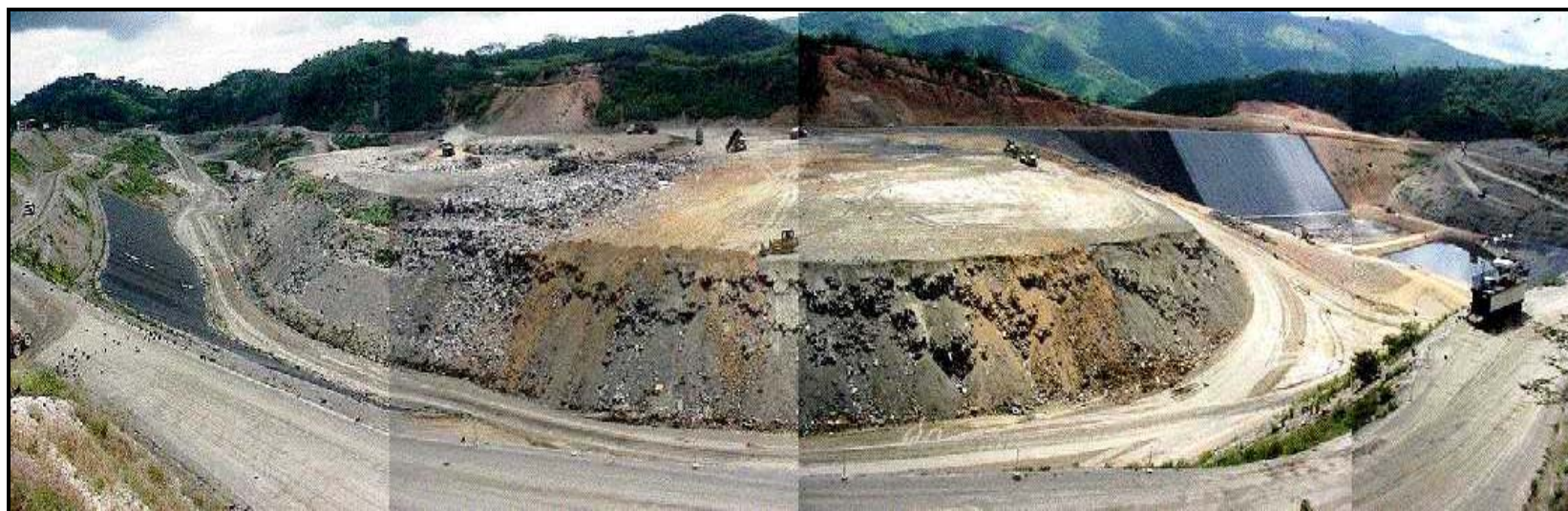
ANEXO C. Vista de las Celdas 1, 2 y 3 del Relleno Sanitario La Bonanza
