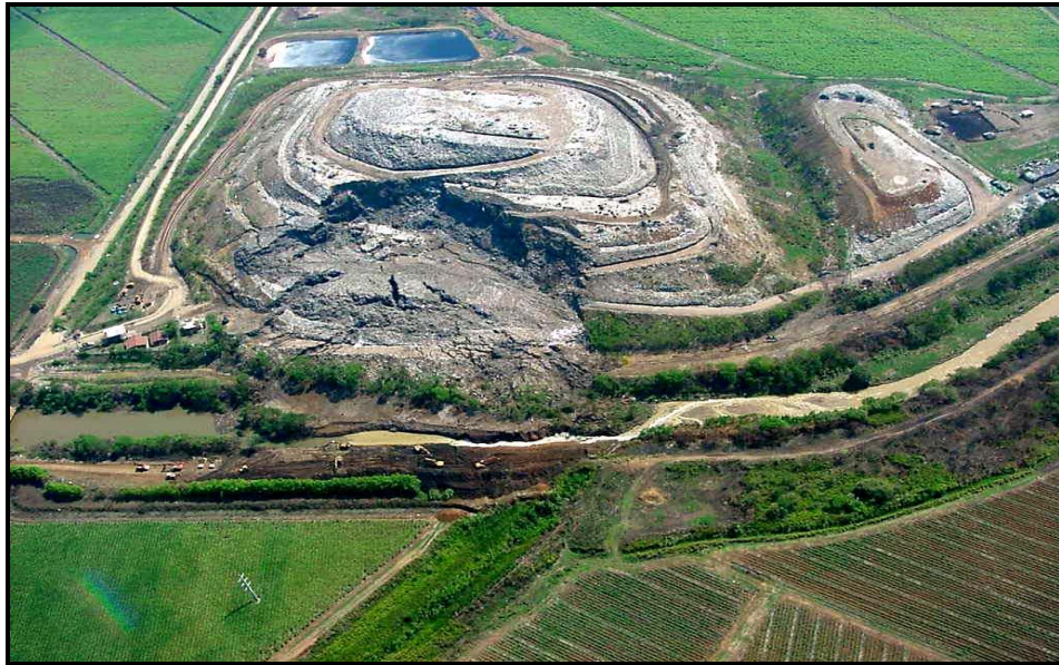
ANEXO B - 1. Vista Aérea de una Falla Circular de un Talud de Basura en el Relleno Sanitario “Navaro” en Cali, Colombia
