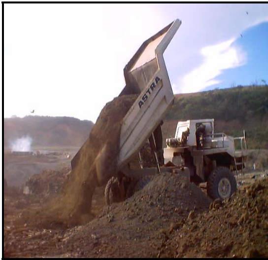
Fig. 50. Descarga del Material de Préstamo
