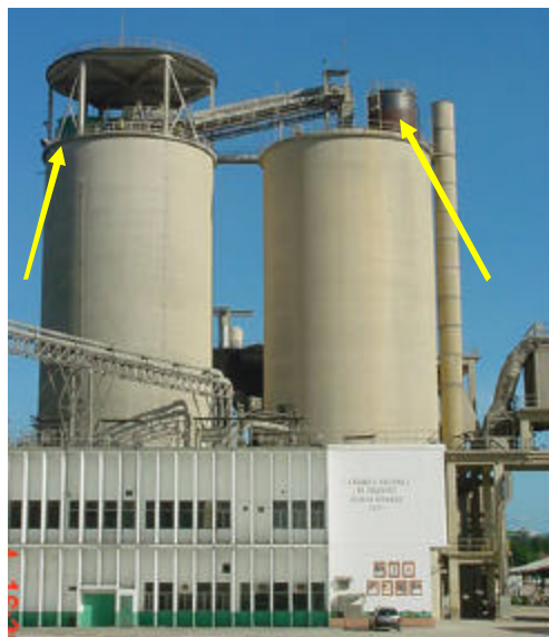
Figura 80 Tanques elevados en los silos de caliza.
