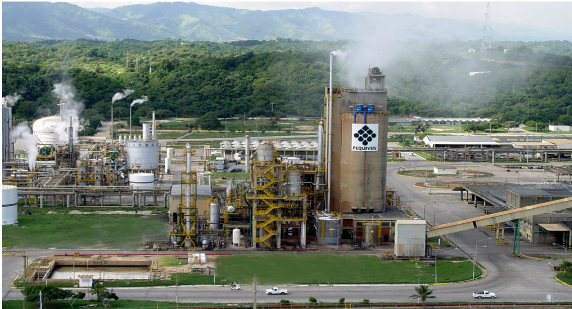
Figura 1.2 - Planta de UREA, Complejo Petroquímico Morón
