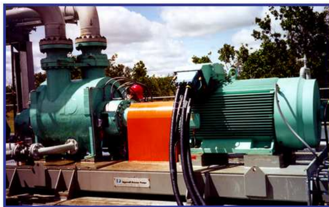
Figura 64. Motor de inducción acoplado a bomba multifásica de doble tornillo.
