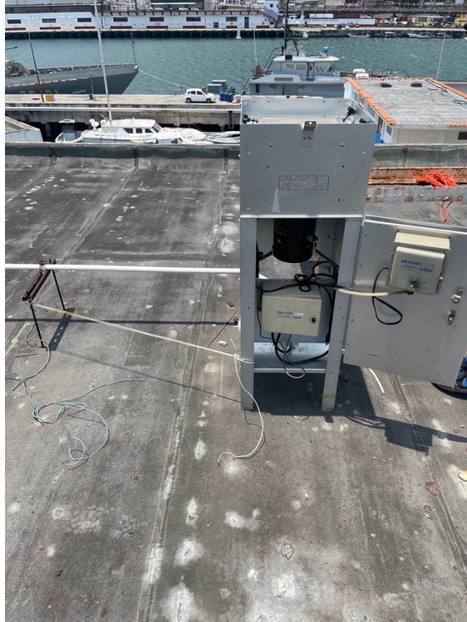
Figura N° 11 Ubicación del muestreador en el techo del edificio de la Guardia Costera.
