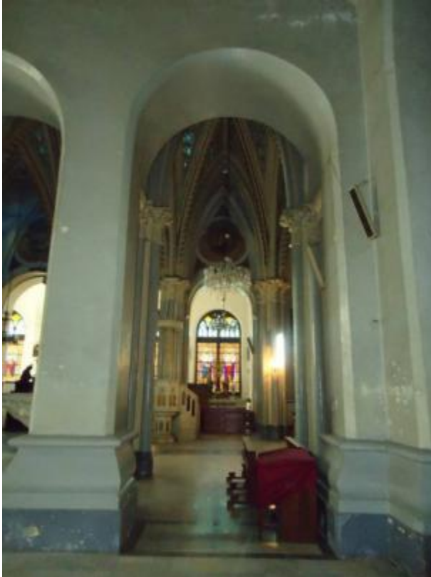
Imagen 40: Arcos de mampostería de la Nave Sur.
