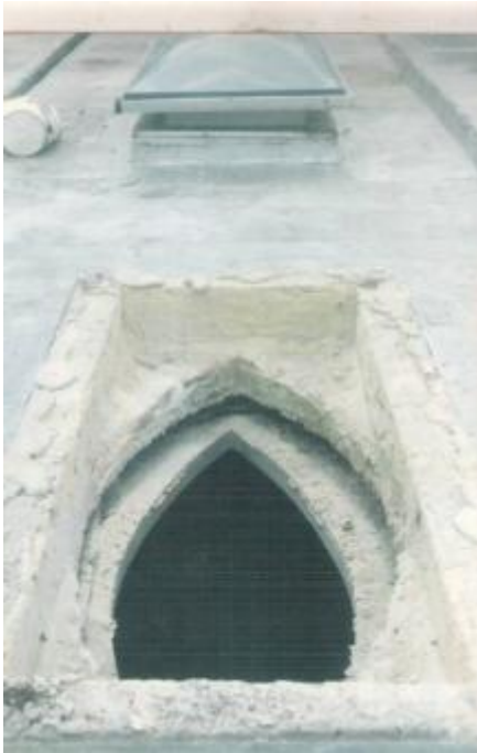
Imagen 66: Cielorraso de las galerías laterales de la nave central visto desde el techo.
