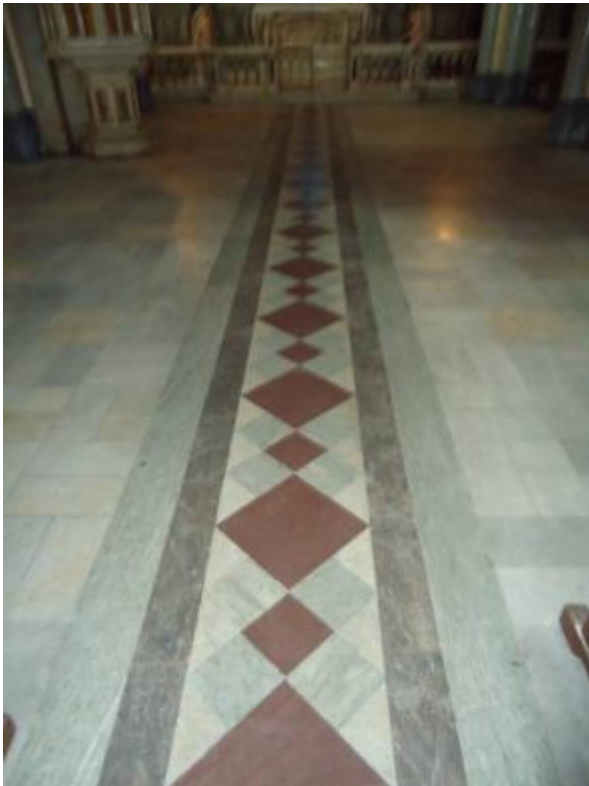
Imagen 50: Pavimento de mármol de la nave central.
