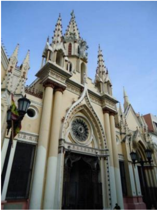
Imagen 20: Tramos de la fachada principal correspondiente a la Nave Central.
