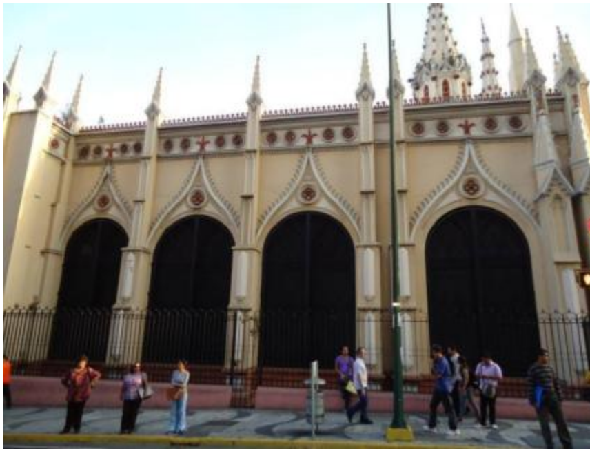
Imagen 23: Fachada Norte. A la derecha el modulo mutilado y reconstruido en estilo en 1952.
