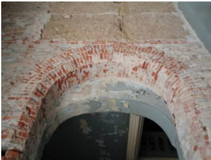
Imagen 38: Mampostería mixta combinada con arcos de ladrillo y sectores de tierra apisonada (tapia) en muro límite de la Nave Sur.
