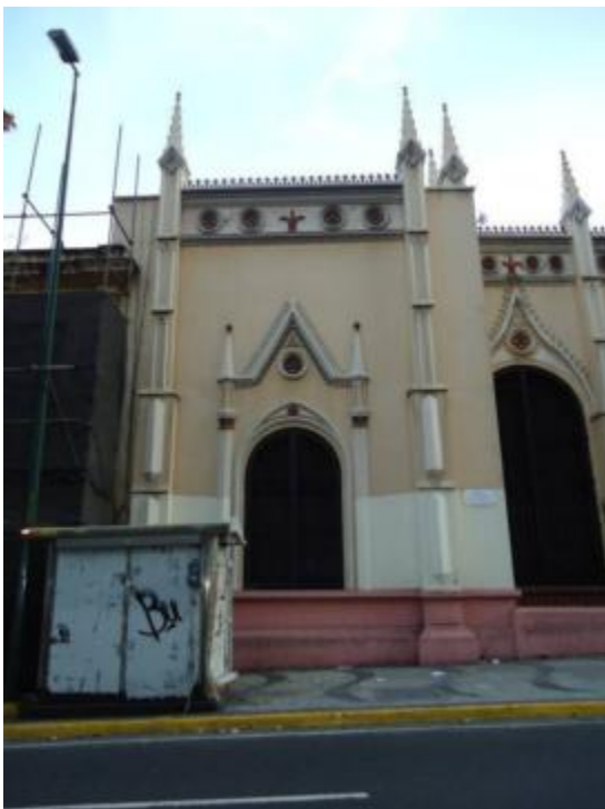
Imagen 25: Tramo de la fachada lateral Norte correspondiente a la Capilla de San Antonio de Padua, que fue reconstruida en 1952 a raíz de la mutilación parcial del volumen para la construcción de la Avenida Urdaneta correspondiente a la Nave Central.
