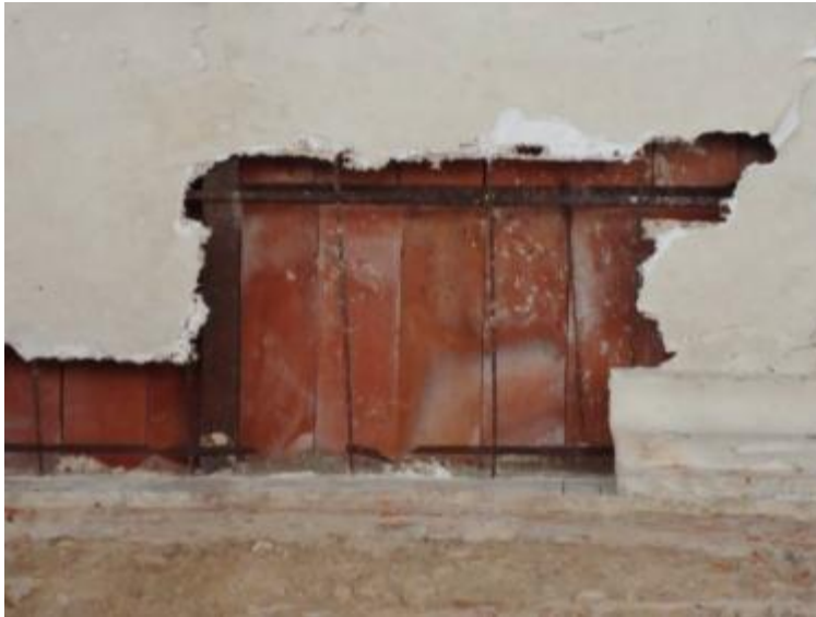
Imagen 44: Losa de concreto sobre tableros conforman las cubiertas actuales de las naves laterales.
