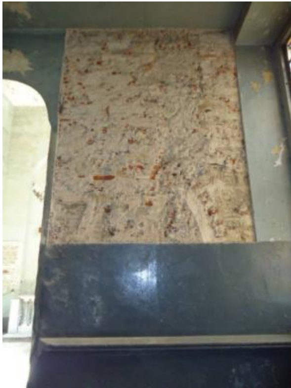
Imagen 39: Mampostería mixta de la Nave Sur.
