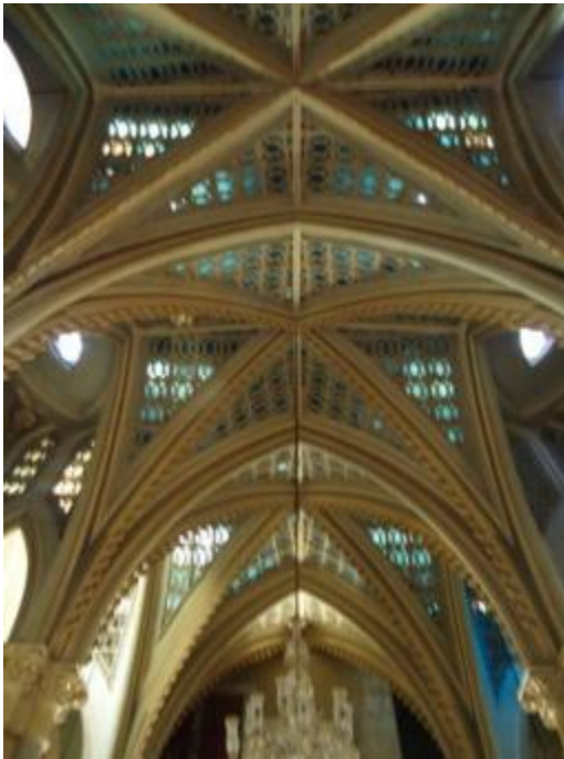
Imagen 64: Cielorraso de la nave central en forma de bóvedas de crucería de madera, escayola y vidrio escarchado azul.
