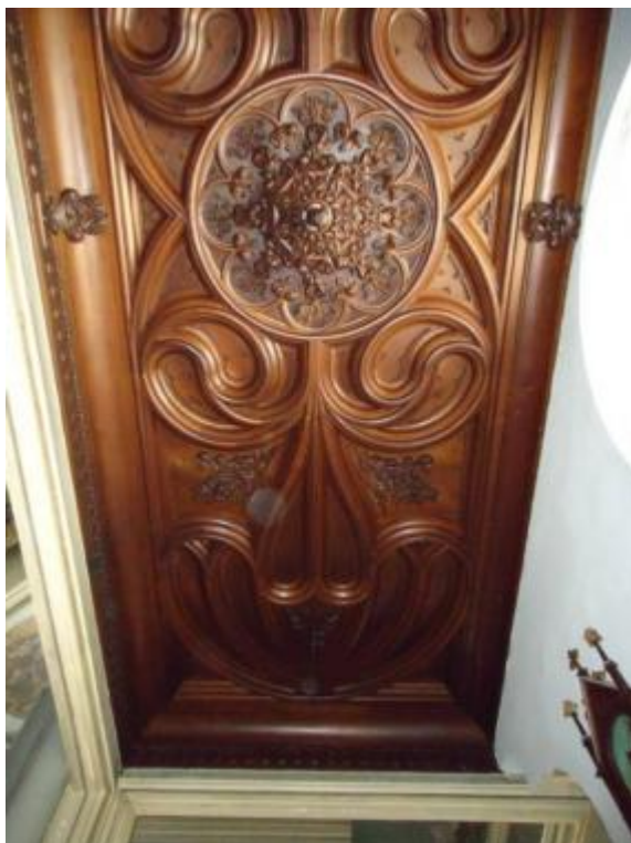
Imagen 69: Cielorraso del soto coro central.
