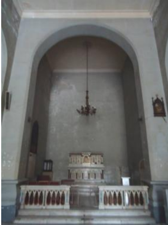
Imagen 45: estructura portante de muros y columnas de la Nave Sur.
