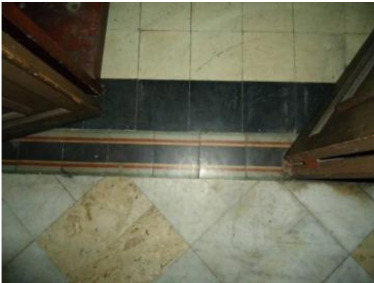
Imagen 51: Pavimento de mosaicos de cemento hidráulico lisos, bordeados por una cenefa de motivos geométricos perimetral en la Capilla de San Antonio. Se presume es el único vestigio que queda de los pavimentos de mosaicos importados de Francia para la Santa Capilla Guzmancista.
