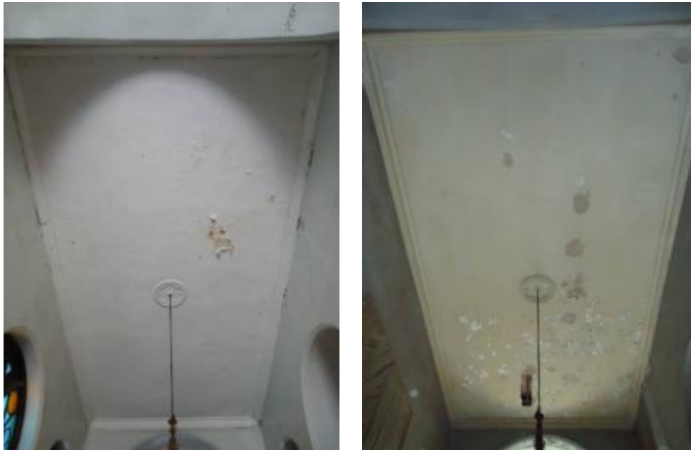
Imágenes 67 y 68: Cielorrasos de las naves Norte y Sur respectivamente.
