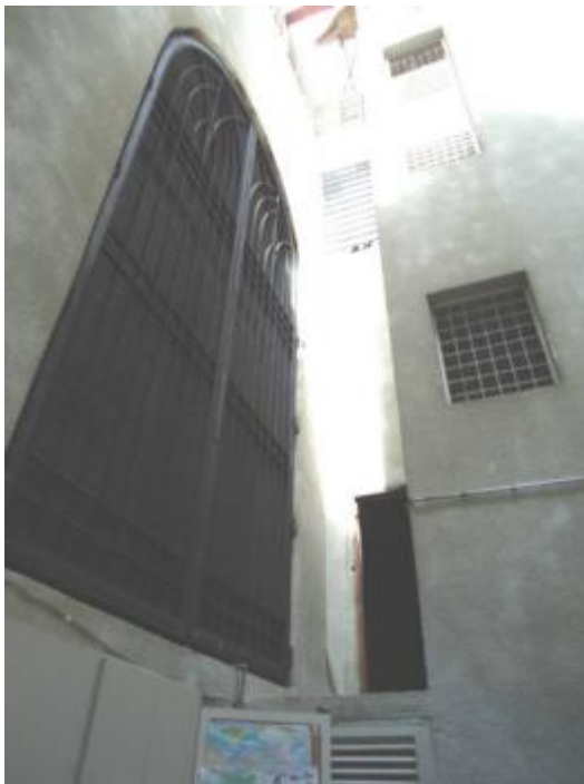
Imagen 26: Tramo de la fachada lateral desde el patio de la Casa Rectoral.
