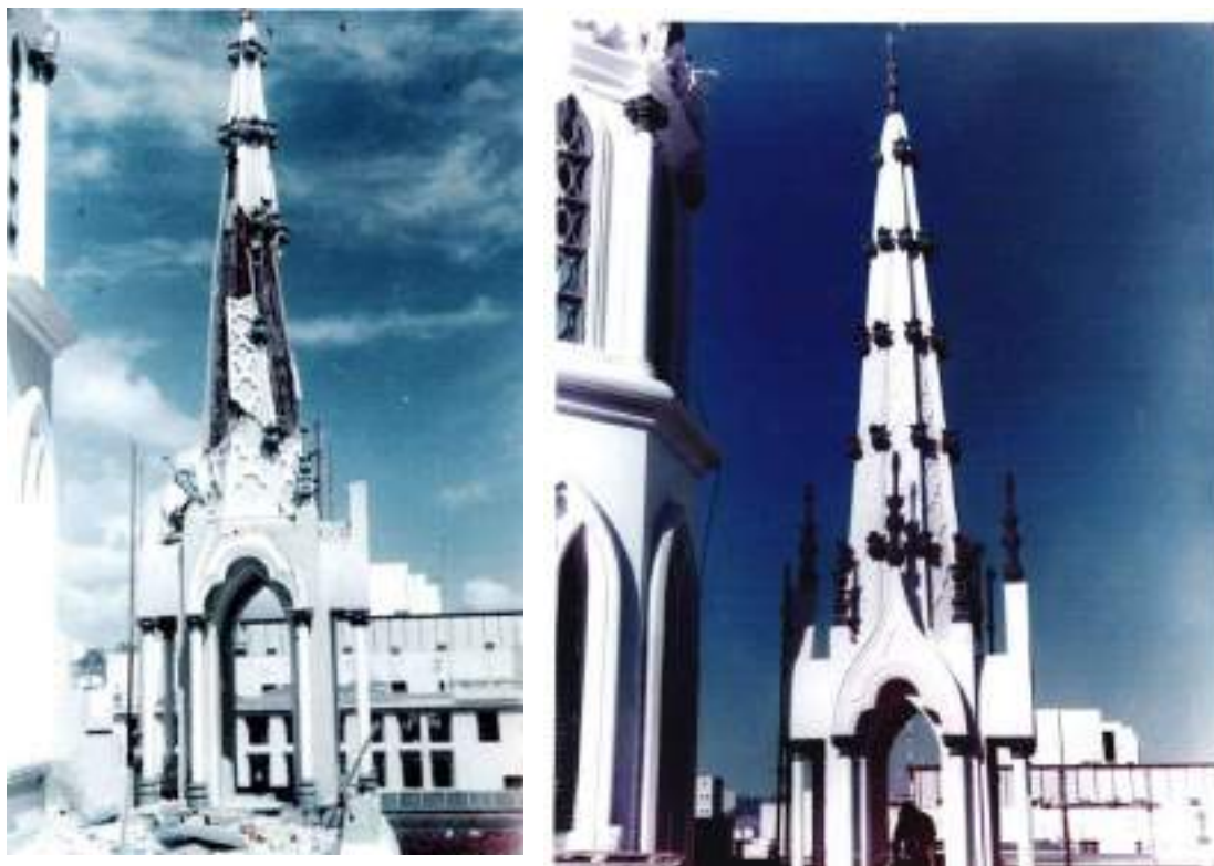
Imágenes 91 y 92: Primer plano del chapitel del baldaquino Norte antes y después de la intervención.
