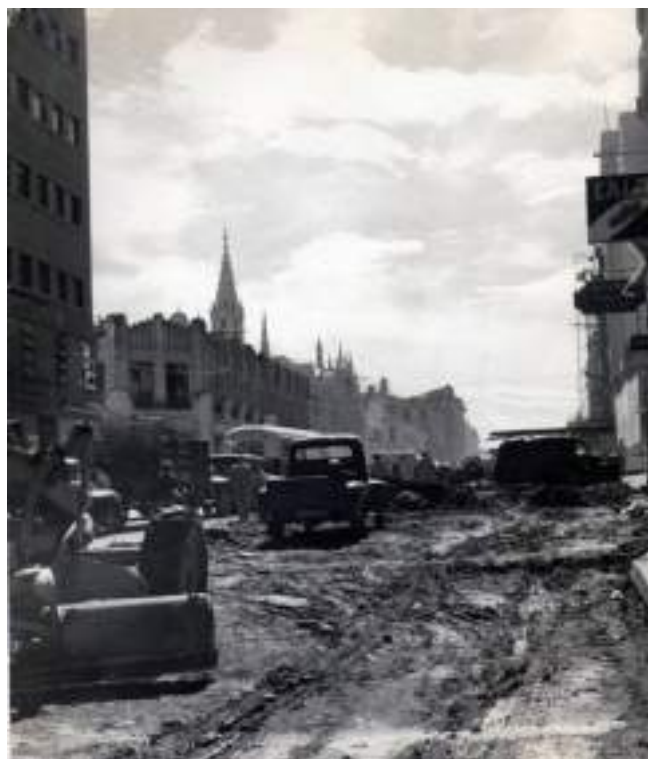
Imagen 75: Construcción de la Avenida Urdaneta.
