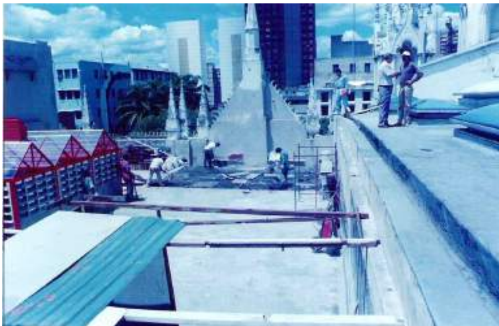
Imagen 99: Obras de impermeabilización de la Nave Sur adelantadas en 1993.
