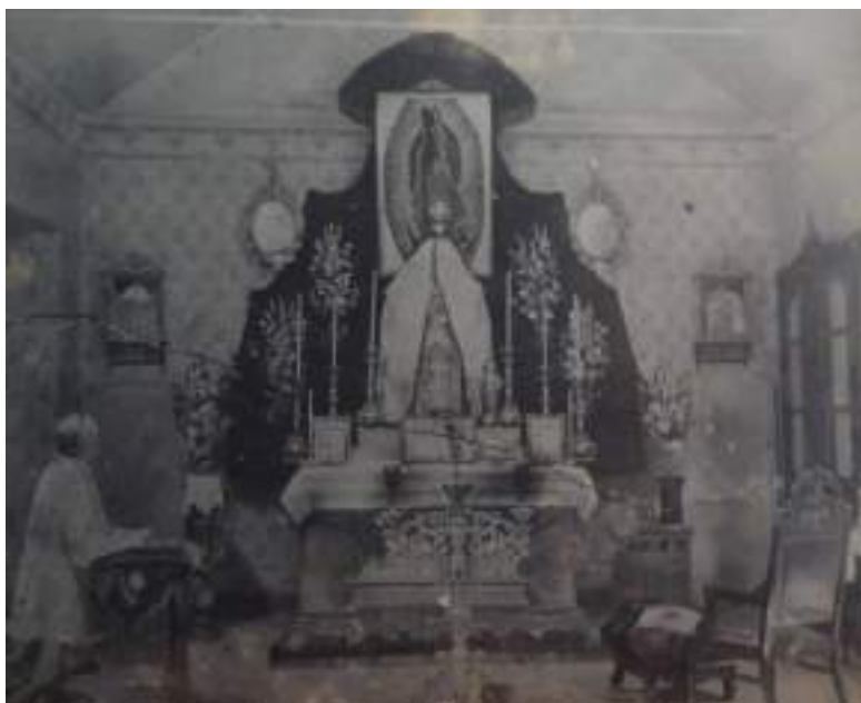
Imagen 40: Interior de la casa del Capellán y sacristía.
