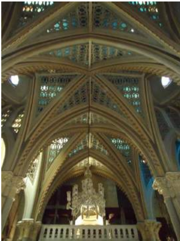
Fuente: Pérez Gallego, Francisco. Bóvedas de crucería de la nave central . Caracas: Marzo de 2011.
