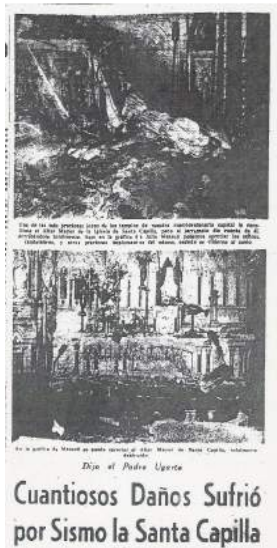
Imagen 77: Daños causados por el terremoto.
