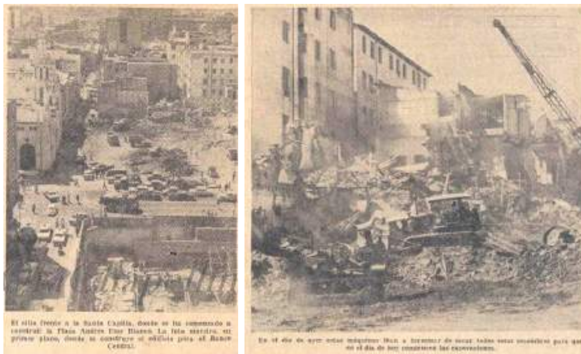
Imagen 83: Demolición del Antiguo Edificio de Telégrafos y la Casa del siglo XVIII donde funcionaba el Ministerio de Obras Públicas para la construcción de la Plaza Andrés Eloy Blanco. En esta imagen de 1969 se aprecian las fases finales de remoción de escombros de los edificios demolidos en la Esquina Suroeste de Santa Capilla.
