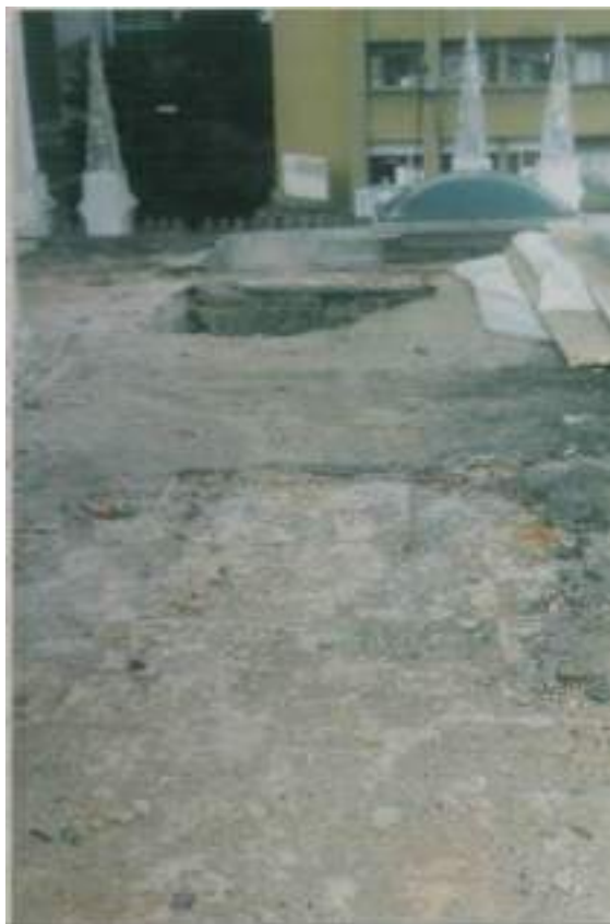
Imagen 97: Cubierta de concreto de la Nave central.
