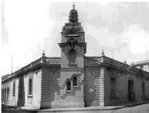
Imagen 84: Edificio de Telégrafos y Teléfonos Nacionales del Ing. Luis Briceño Arismendi.
