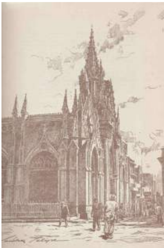
Imagen 87: Esquina de Santa Capilla después de la demolición de la Capilla del Santo Cristo.
