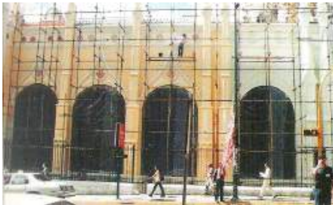
Imagen 104: Fachada Oeste en proceso de restauración 2000.
