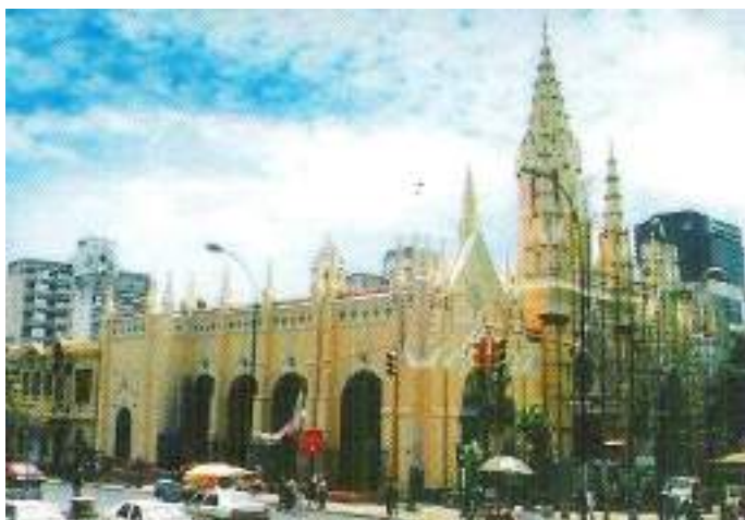
Imagen 103: Fachada Norte en proceso de pintura (2000).
