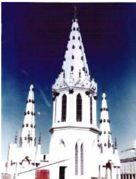
Imagen 94: Primer plano de la aguja después de su reconstrucción. Obsérvese el volumen agregado adosado a la base de la torre para su comunicación con el coro.
