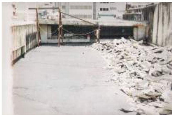
Imagen 102: Techo nave Norte en proceso de demolición de pendientes y sobre pisos agregados.
