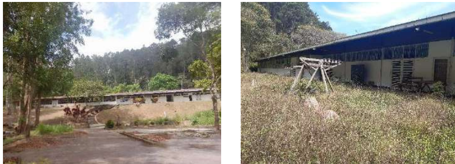
Figura 4. El Pabellón 5 en la Universidad Simón Bolívar, fachada norte (izq.), y fachada sur (der.)
