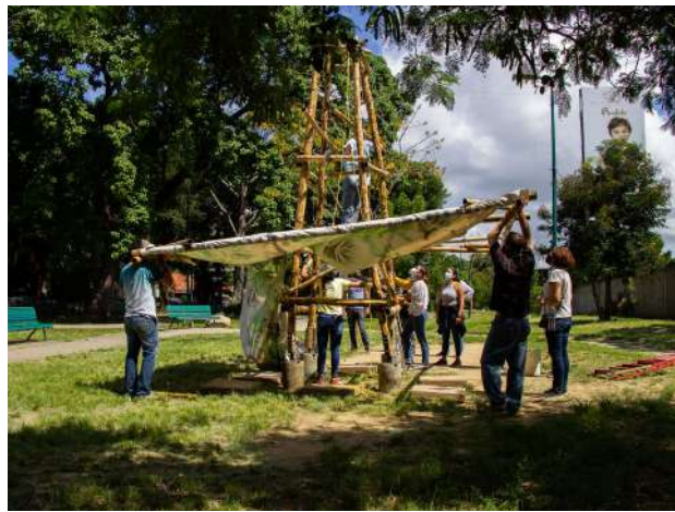
Imagen 9. Construcción del pabellón ecológico para la recolección de aguas de lluvia con recolector de energía solar en el parque ARUFLO, La Floresta, con estudiantes del servicio comunitario.
