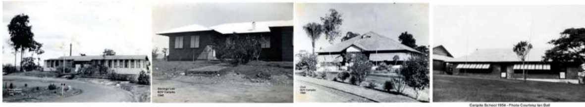
Imagen 8: edificaciones de apoyo en campos de Caripito.
