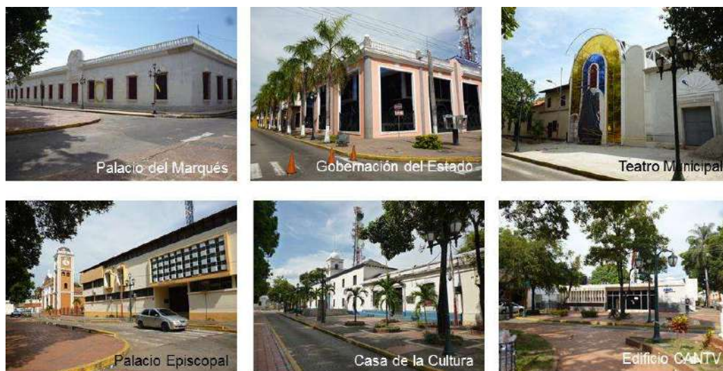
Figura 1: Edificaciones del perímetro de la Plaza Bolívar de Barinas
