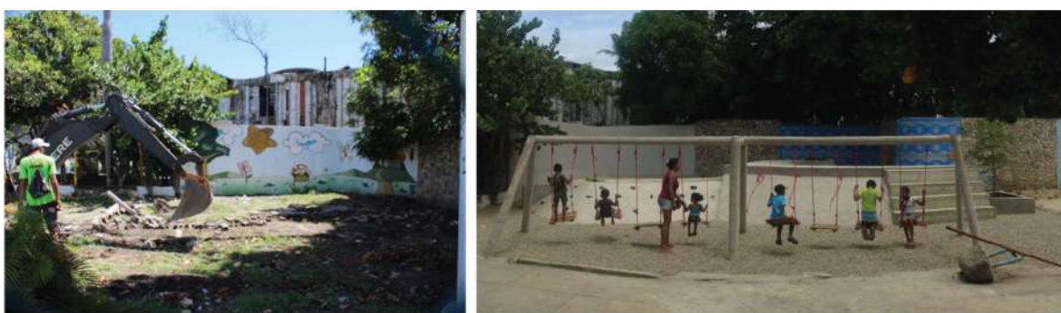
Figura 1. Fotos Parque del Balneario Naiguatá, previa a la intervención y posterior
