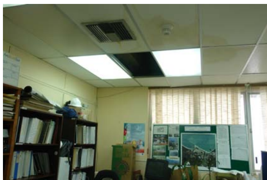
Figura 31. Oficina 607 del Edificio de Seguridad, Higiene y Ambiente. Refinería El Palito.
